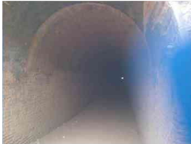
Imagen 32. Primer túnel con una longitud de 360m (Foto: Miriam Sánchez)
