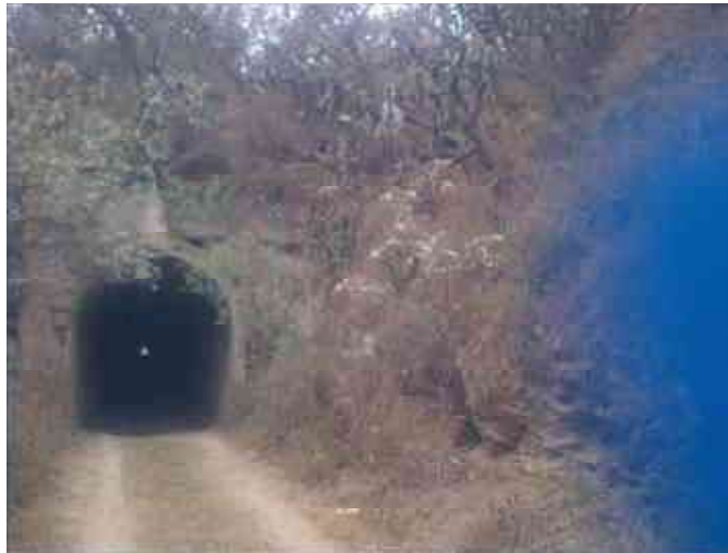
Imagen 33. Acceso al segundo túnel el cual tiene una longitud de 310 m (foto: Miriam Sánchez)
