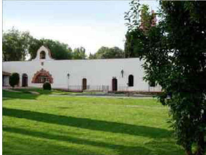
Imagen 23. Interior de la Ex hacienda de Caltengo (foto: Octavio Jiménez)
