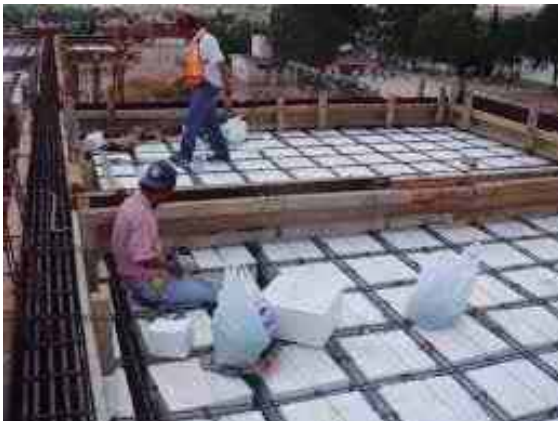
Ilustración 4.1.1: Construcción de losa de casetones. [Fuente: www.google.com .]
