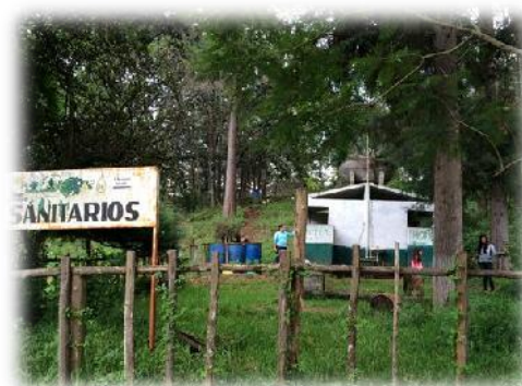
Imagen No. 26. Sanitarios Fuente: Propia
