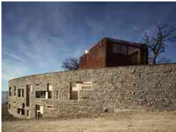
Ilustración 20 : Se puede apreciar el revestimiento de la piedra que tomaron al momento de la excavación
