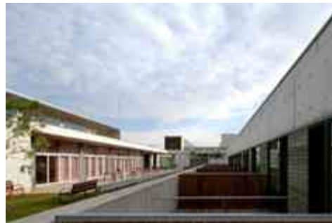
Ilustración 23 : Se muestra una parte exterior de las habitaciones, por donde se iluminan y ventilan
