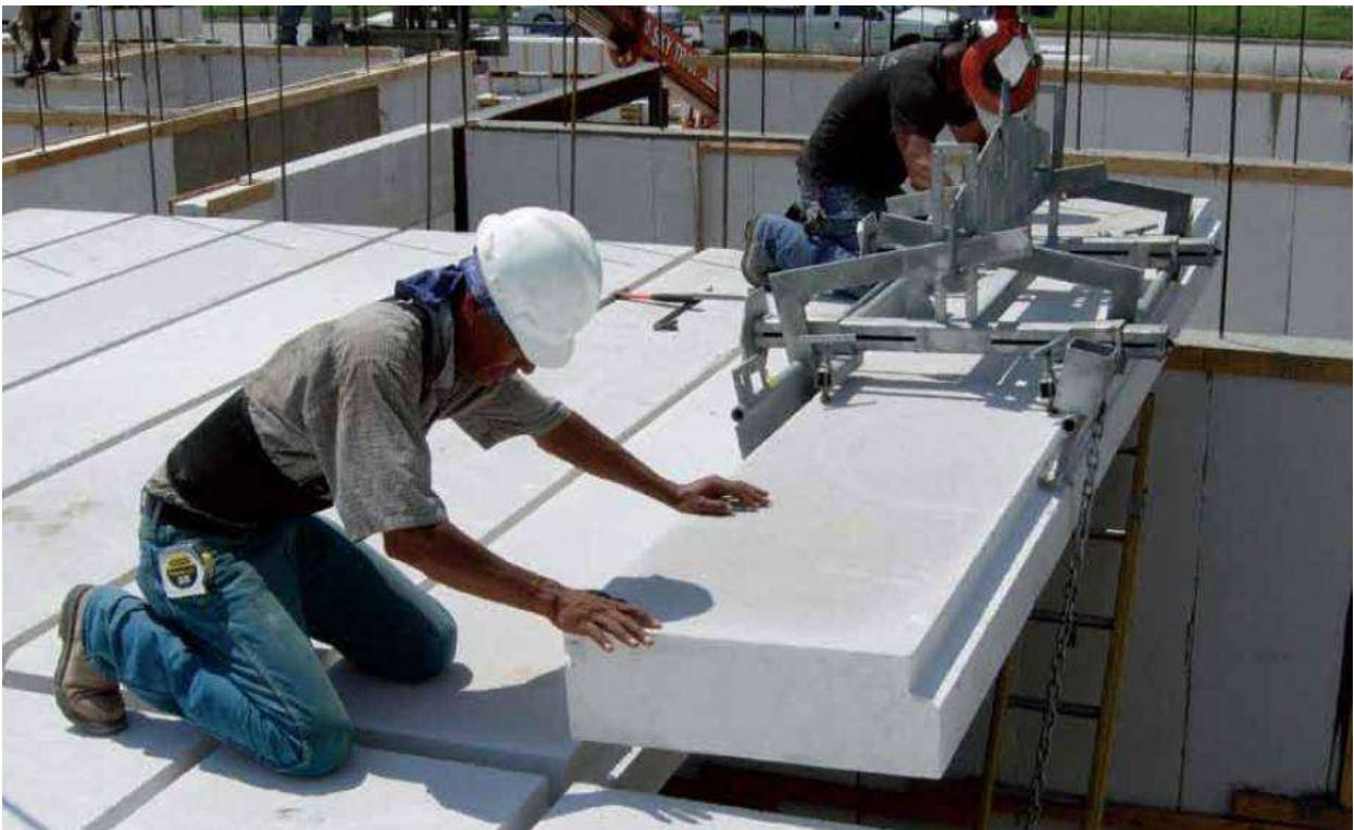
Imagen 40. Colocación de paneles de concreto celular para losas.
