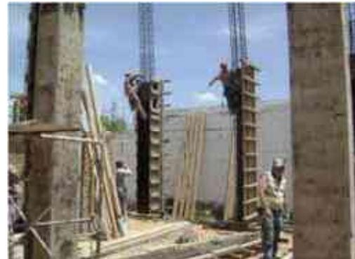
Imagen 32: columnas de concreto armado
