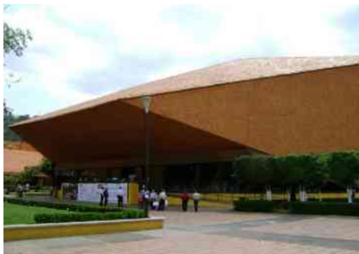
FIG. 7 Fachada de Teatro Morelos, Morelia Mich. Foto Miguel Santiago
