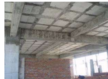
Imagen. 53 Losa reticular Fuente: Autor.
