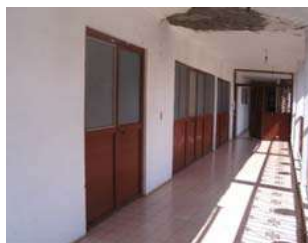
Imagen. 5 Fuente. Autor. Losa en mal estado.
