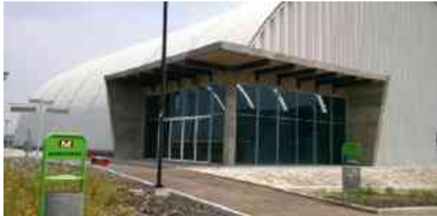
Fig. 59, Alberca fachada unidad bicentenario. Foto Enrique Melchor Rodríguez.
