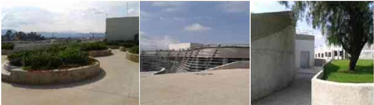
Fig. 49, foto de instalaciones del poliforum Digital en Azotea, Morelia Michoacán. Foto Enrique Melchor Rodríguez.
