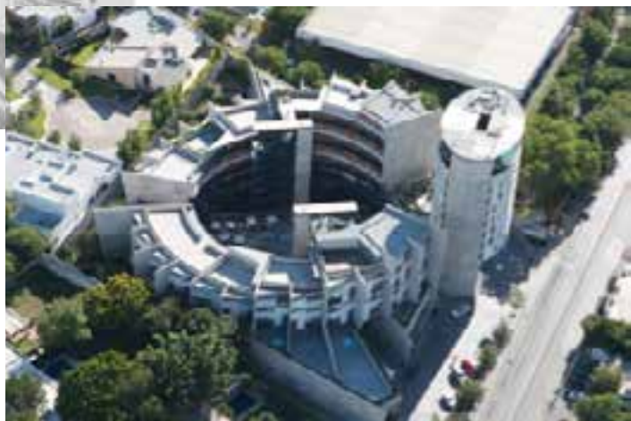
Fig 17. Vista aérea de hotel habita en Monterrey. Foto int
