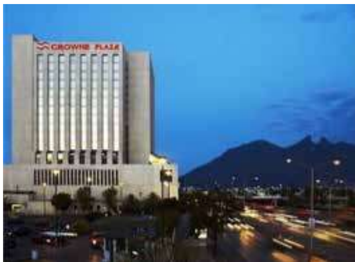
Fig 6. Hotel Crown Plaza en Monterrey. Foto int.
