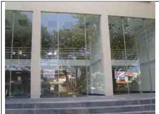
Imagen 4.10, Aplicación de vidrios estructurales. Fuente: Fotografía del autor.
