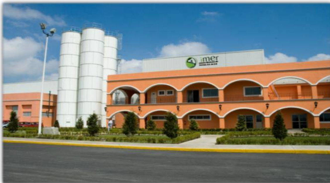
Imagen 3.5, Fachada de planta IMER, ubicada en Parque Industrial de Toluca de Lerdo Estado de México. Fuente:
