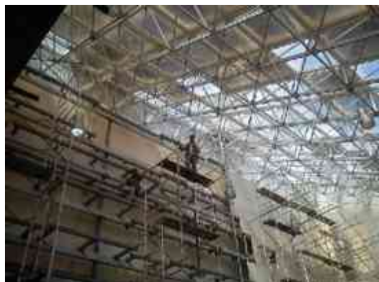
Imagen 4.5, Aplicación de sistema constructivo tridilosa. Fuente: Fotografía del autor.
