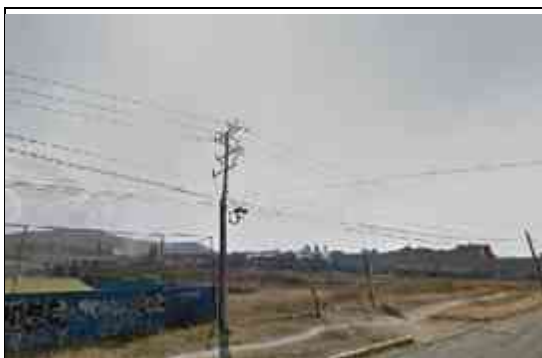
Imagen 2.27, Infraestructura urbana de la zona (energía eléctrica y telecomunicaciones). Fuente: Fotografía del autor.
