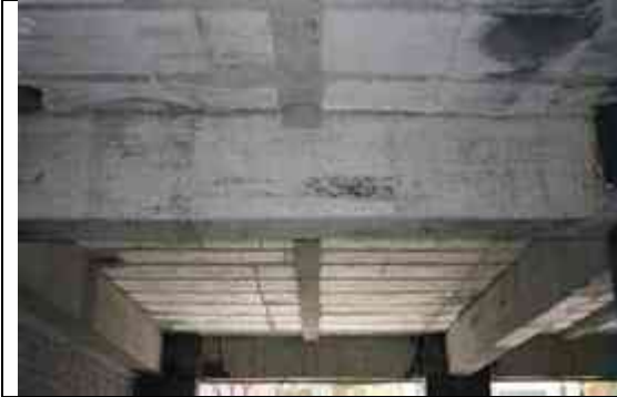
Imagen 4.8, Aplicación de sistema constructivo losa reticular. Fuente: Fotografía del autor.
