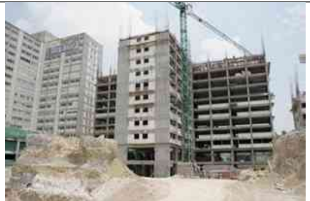
Imagen 4.9, Aplicación de sistema constructivo losa reticular. Fuente: Fotografía del autor.
