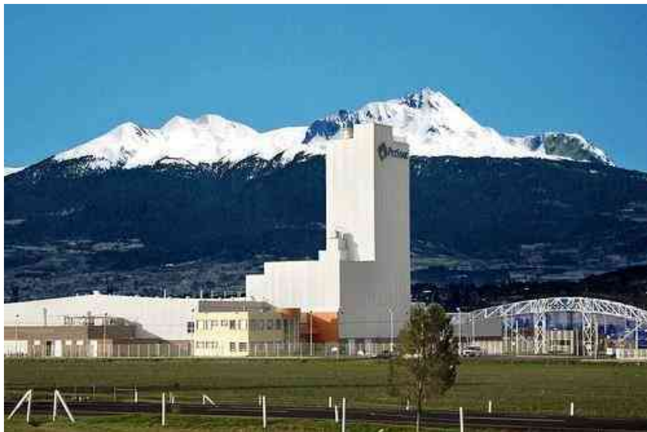
Imagen 3.8, Vista sureste de planta PetStar, ubicada en Toluca de Lerdo Estado de México. Fuente: https://farm8.staticflickr.com/7242/7373310114_5ff8cf3bb6.jpg . Consulta realizada el día 28 de agosto de 2013.
