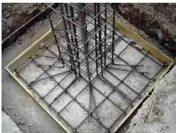
Imagen 4.1, Armado de una zapata aislada. Fuente: Fotografía del autor.
