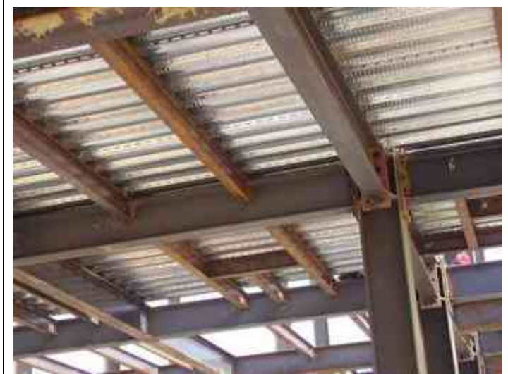
Imagen 4.6, Aplicación de sistema constructivo losacero. Fuente: Fotografía del autor.
