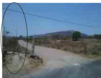
Imagen 3.2.- Lineas de alta tensión de C.F.E. Imagen tomada en campo
