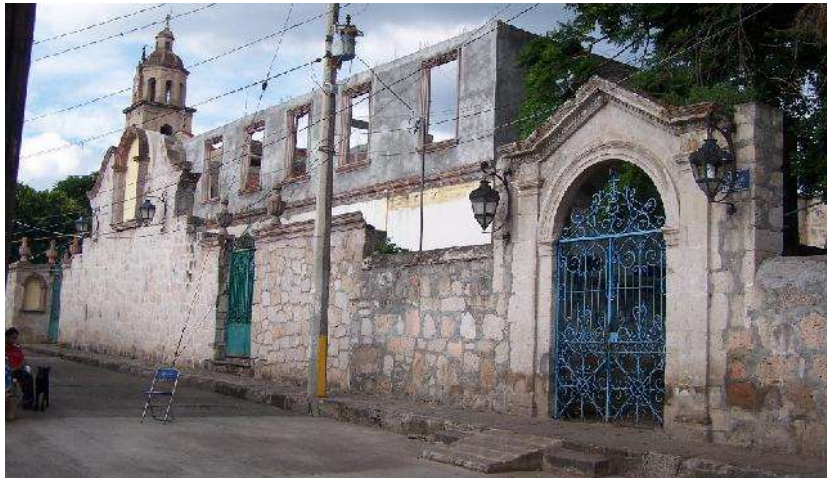
Fotografía 4.- Fachada principal (poniente) del Centro de usos múltiples, acabado en cantería con puertas de herrería. (2013) Foto: Mireya Ayala Hernández.
