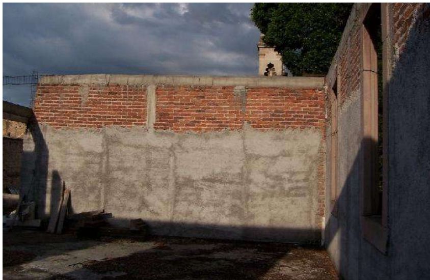
Fotografía 9.- vista de planta alta norte se observa muros de tabique rojo recocido. Foto: Mireya Ayala Hernández. (2013)
