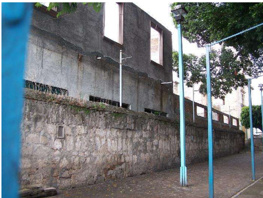
Fotografía 6.- vista de fachada sur en obra negra. (2013) Foto: Mireya Ayala Hernández.
