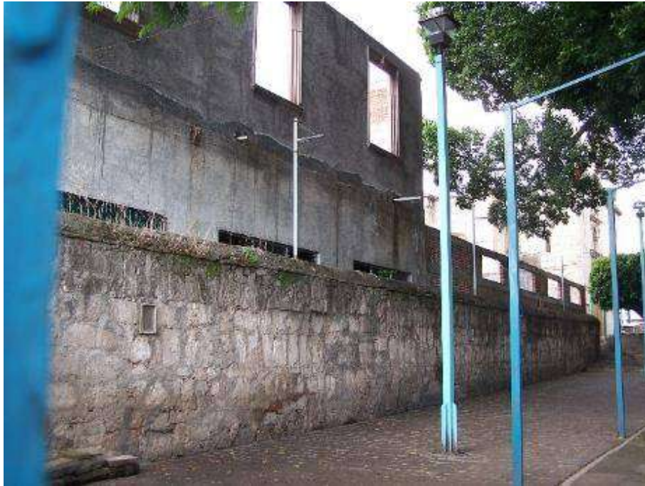
Fotografía 22.- vista de acabado en muro, aplanado fino con mortero. Foto Mireya Ayala Hernández. (2013)
