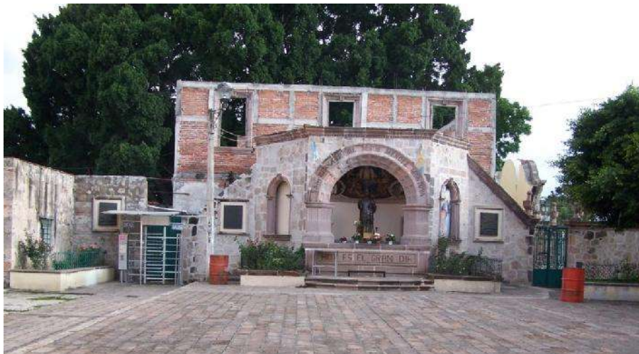
Fotografía 5.- Fachada secundaria (norte) a base de tabique rojo recocado. Foto: Mireya Ayala Hernández (2014)
