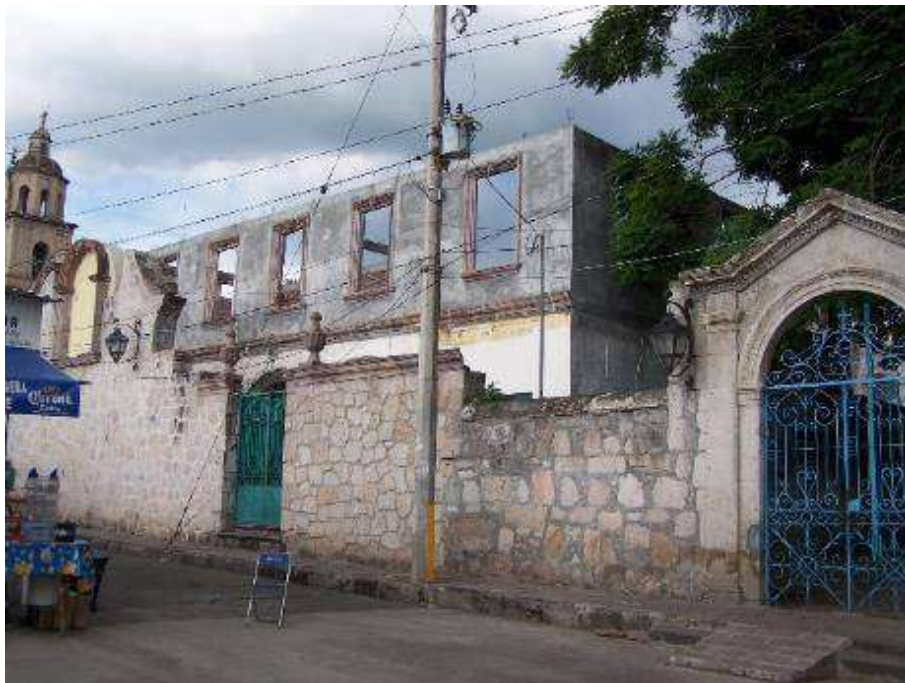
Fotografía 21.- Recubrimiento de cantera en fachada principal del Centro de Usos múltiples y en la entrada al Santuario de la Virgen de la Escalera. Foto Mireya Ayala Hernández. (2013)
