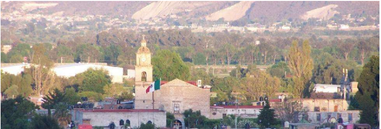
Fotografía 1.- Foto del conjunto parroquial, de izquierda a derecha, Parroquia de San Miguel Arcángel, Ex convento Franciscano, Santuario de la Virgen de la Escalera (fondo) y Centro de Usos Múltiples Actual.
