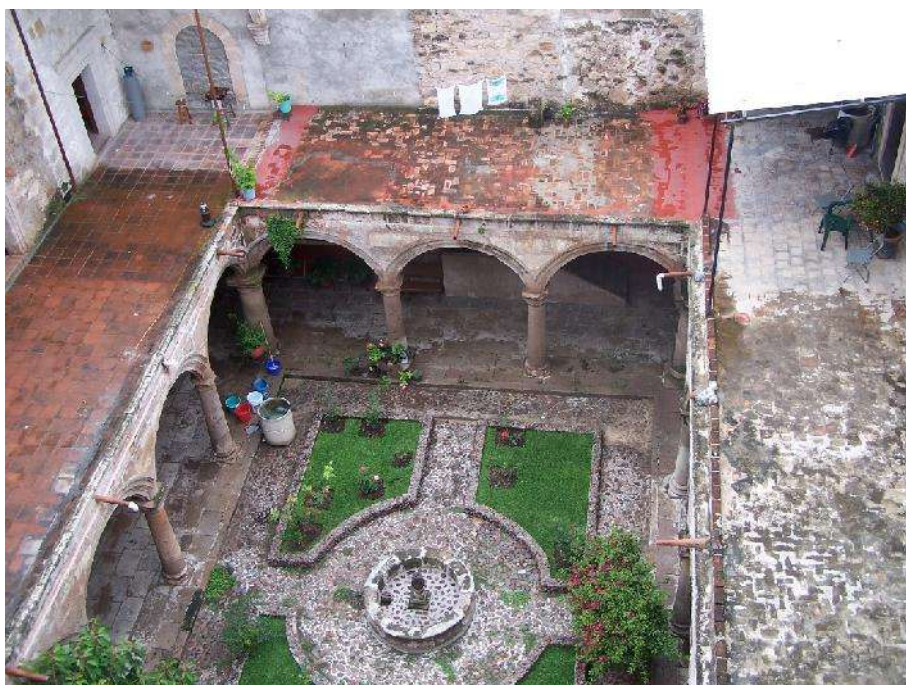
Fotografía 16.- Vista aérea del claustro del convento Franciscano de Tarímbaro, donde se puede ver los arcos de medio punto a base de cantería. Foto: Mireya Ayala Hernández. (2013)
