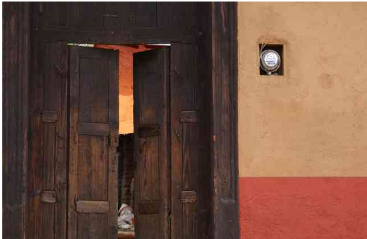
Restauración de vivienda familiar en Santa Fe de la Laguna, Municipio de Quiroga Michoacán. Fotografía, Arq. Fernando Mora Serrano DATA 2008.
