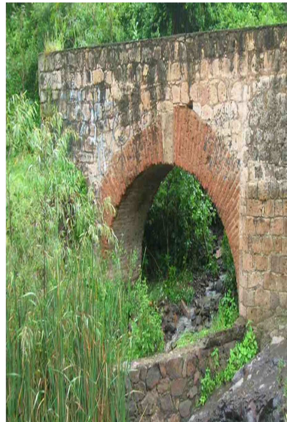
Arco del canal de demasías en los vestigios de Los Filtros Viejos. Fotografía de Carlos Peregrina Sánchez.
