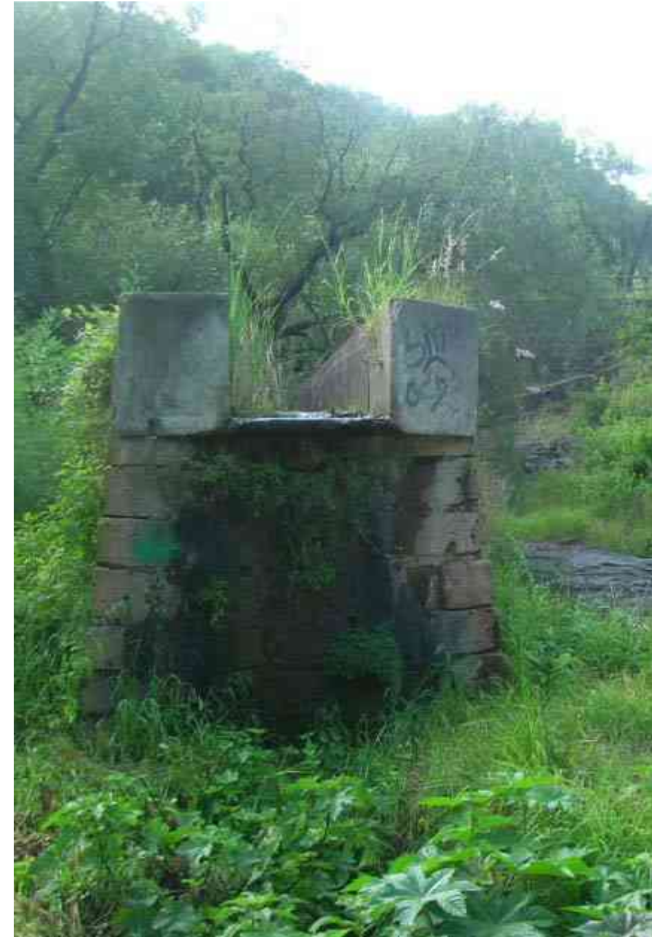
Boca de canal Vestigios de Los Filtros Viejos. Fotografía, Carlos Peregrina Sánchez
