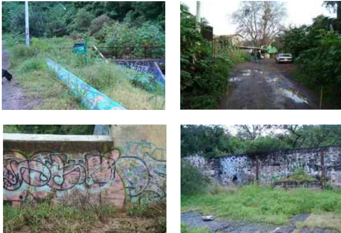
Contaminación visual y afectaciones en entorno e infraestructura de en Los Filtros Viejos. Fotografías, Carlos Peregrina Sánchez.
