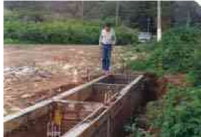
Biodigestor Agronómico Planta Piloto ubicada en la Ciudad de Pátzcuaro, Michoacán, fosas de tratamiento primario.
