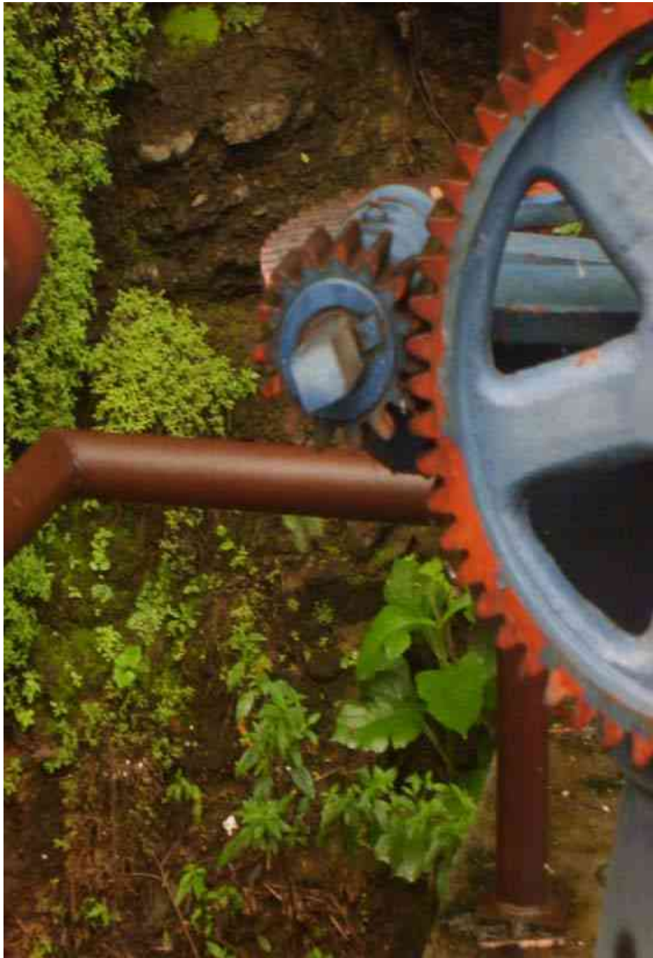
Mecanismo de compuerta de la primera cortina para el control de avenidas en Filtros Viejos. Fotografía, Carlos Peregrina Sánchez.
