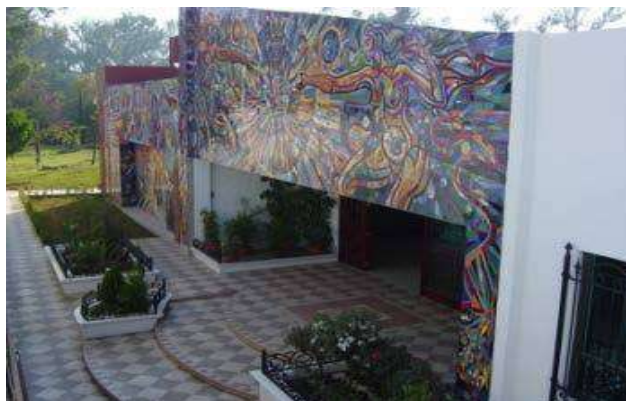
Ilustración II: Acceso a la Biblioteca del IMCED "Campus Morelia"
