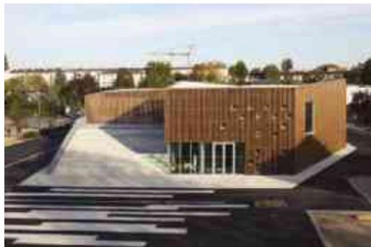
“El marco de este edificio de hormigón está cubierto por un revestimiento de madera tratada el cual pretende crear un ambiente acogedor en un entorno difícil”
