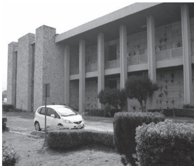
Imagen 14.- Fachada de edificio tipo Mausoleos del Angel
