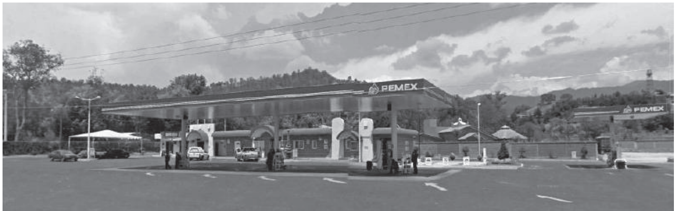
Imagen 3.- Gasolinera 1 Valle verde
