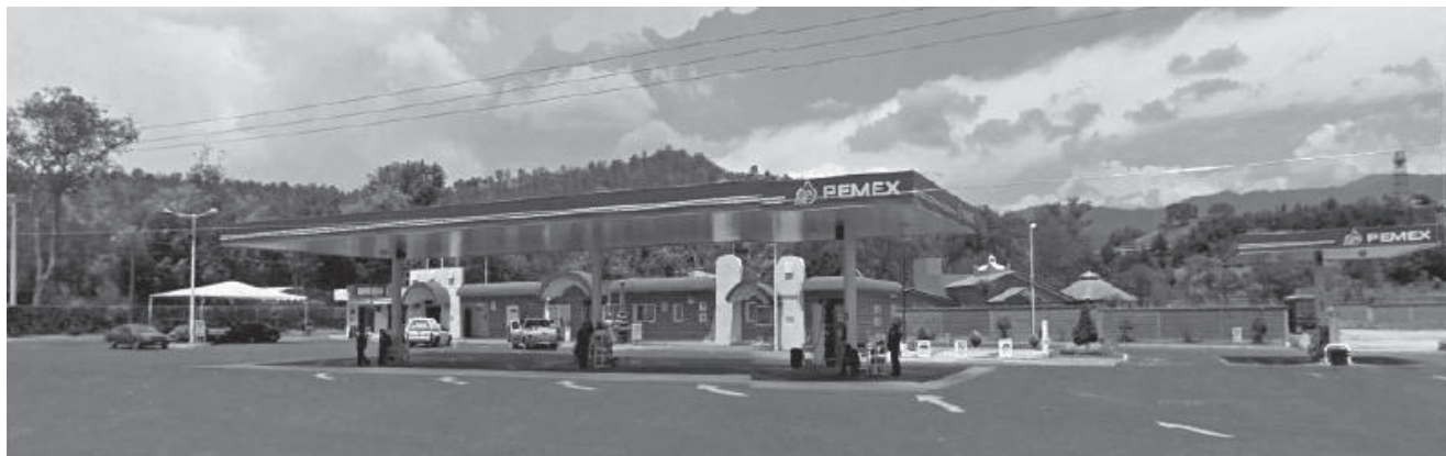
Imagen 4.- Gasolinera 2 Valle verde
