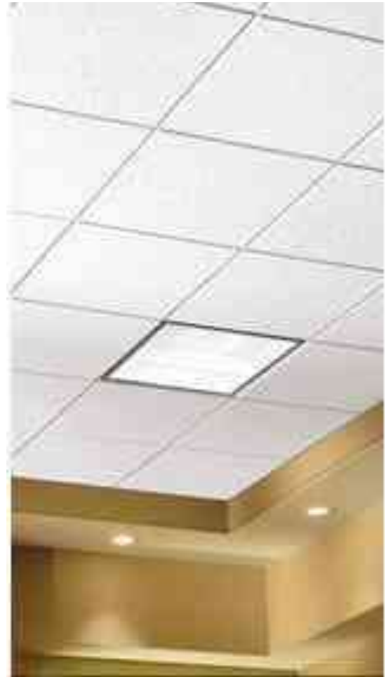
Foto 68. Terminado de falso plafón, ibídem.
