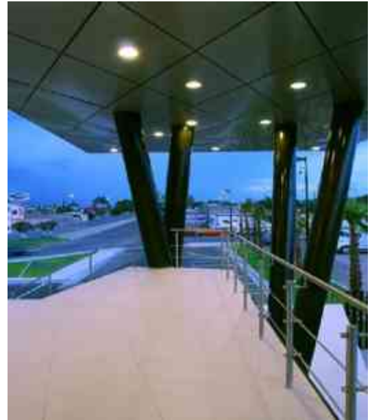
FOTO 51. Terraza del edificio de Darcons, vista suroeste. http://www.archdaily.mx/68141/edificio-darcons-5-arquitectura-en-proceso/?lang=MX.pagi . consultada en septiembre del 2013
