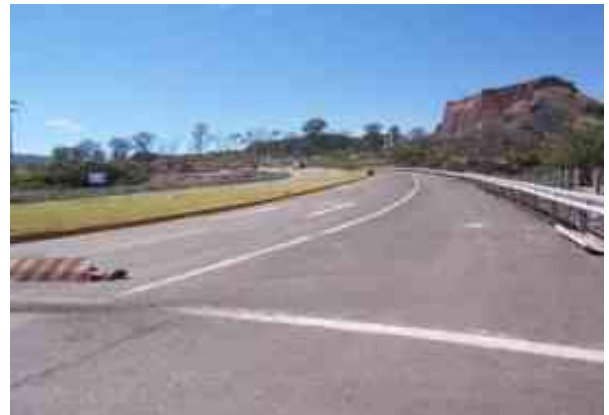
Foto. 30 Carretera Morelia-Quiroga, foto tomada por la autora.
