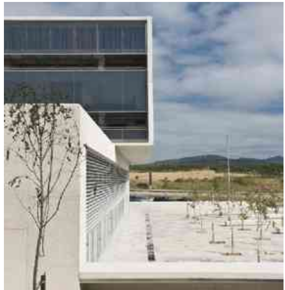
Foto 42. vista lateral de las oficinas de tFcsa,navarra. http://arkineta.com/breves/edificio-de-oficinas-de-tracasa-navarra_a560
