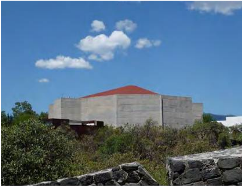
Imagen 34 Cubierta de Sala Nezahualcoyotl.
