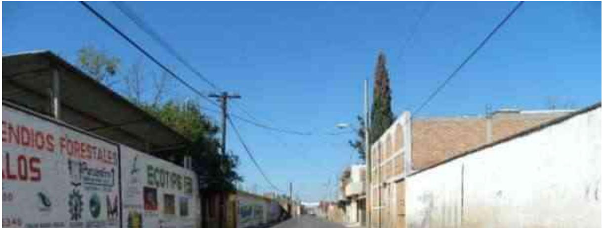
Imagen 57 El servicio de energía eléctrica junto con la línea de teléfono y alumbrado.
