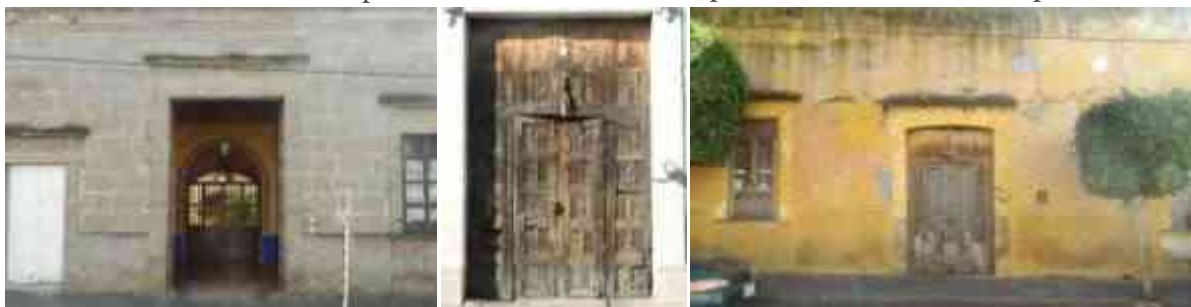
Imagen 51 Elementos arquitectónicos de la época virreinal que aún prevalecen en el centro urbano. 65
