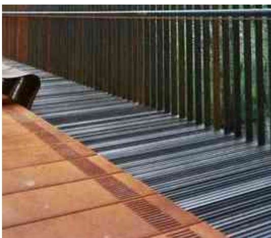
Imagen 21 Acero como materia principal en el espacio denominado “La Lira” © RCR Architectes 2013
