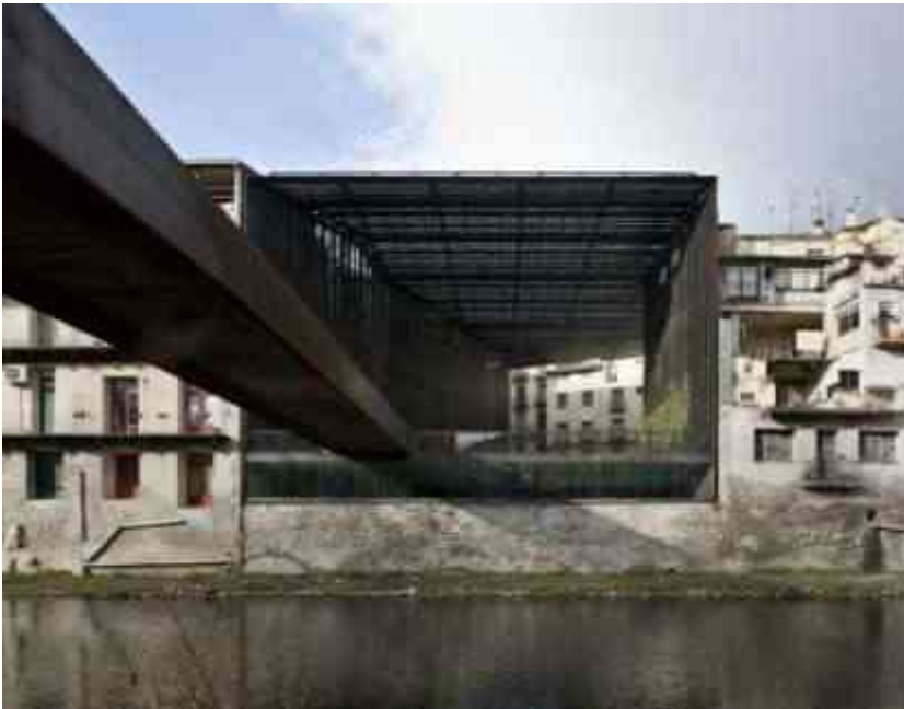
Imagen 18 Vista Exterior del espacio multifuncional el cual funge principalmente como teatro semi-abierto, envuelto parcialmente por una estructura homogénea de acero y dando paso al espacio el corredor sobre el rio Ter como acceso principal. © RCR Arquitectes 2013 34
