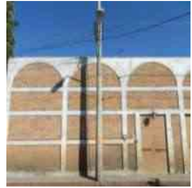
Imagen 56 Alumbrado Público en gran parte de la calle frente al predio.
