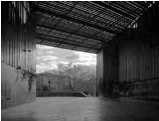
Imagen 20 La estructura principal del espacio abierto construida por medio del forjado de los elementos estructurales en su totalidad de acero © RCR Architectes 2013
