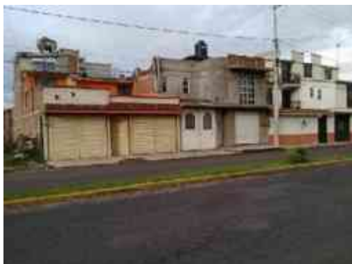
Fig. 21, Casas habitacional-Comercial. LMSA
