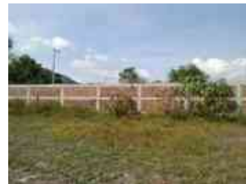
Fig. 39, A3 Vista hacia la colindancia casa habitación de 1 piso. LMSA.
