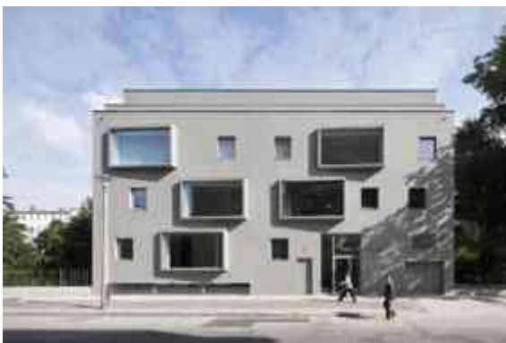
Fig. 59, Edificio en el centro de Berlín. [Domusxl.com/monotonia-rota/. 02/08/14].
