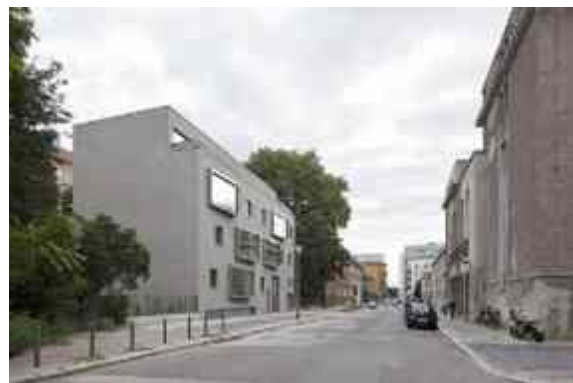
Fig. 58, Edificio en el centro de Berlín. [Domusxl.com/monotonia-rota/. 02/08/14].
