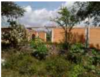
Fig. 38, A1 Vista hacia la calle Peñuelas. LMSA.
