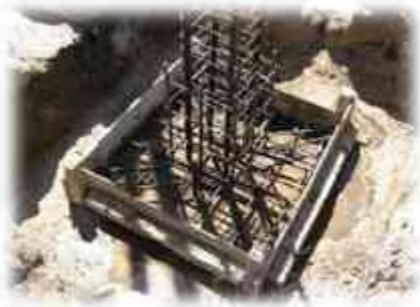
Las zapatas son miembros estructurales que se encargan de transmitir la carga de columnas, pilares o muros, incluyendo su peso sobre un área de terreno suficiente para que los esfuerzos transmitidos estén dentro de los límites permitidos para el suelo que la soporta.<sup>11</sup>
