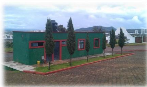
42 Fotografías del terreno estado actual.
