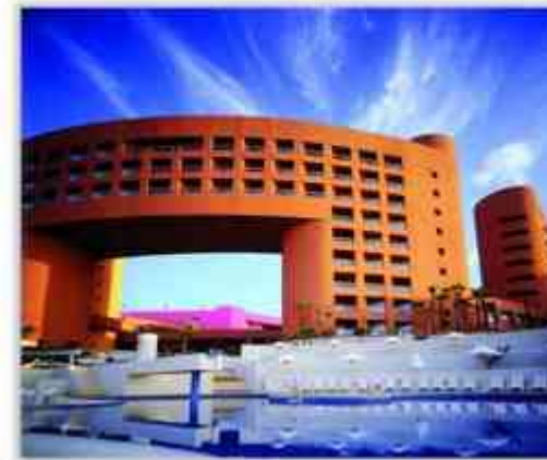
Imagen 25. Hotel Westin Regina los Cabos.
