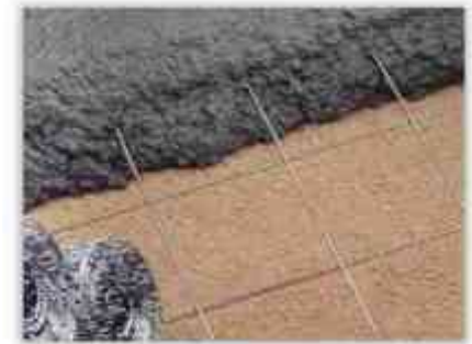
Imagen 113. Firme de concreto.
