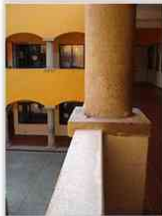
Imagen 103. Pasillos Casa Alianza.
