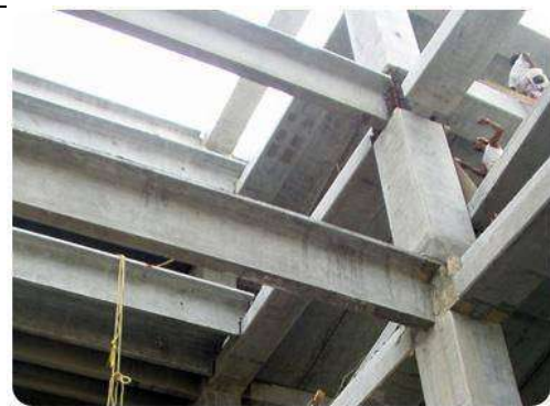
Trabes de concreto armado (GRUPO CONSTRUCTOR SEPSA S.A. DE C.V., 2015)
