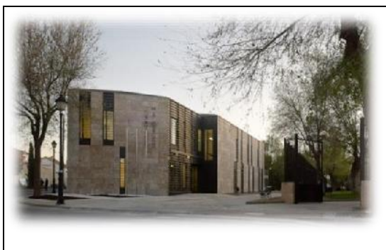
Fachada principal de los juzgados (Estudio MMASA, 2013)
