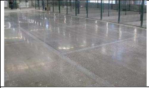
Piso de concreto pulido (Kisco, 2012)
