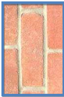
Ilustración 6 piso de tabique aparente
