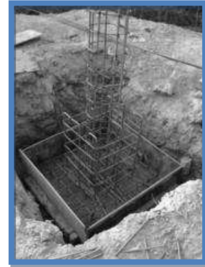
Ilustración 1 proceso constructivo Zapata Aislada
