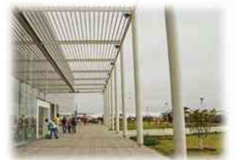
Fig.16 pabellón artesanal y tecnología Recinto Ferial de Morelia http://www.google.com.mx/search?q=recintos+fer
