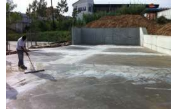
Imagen 6-3.- Muros de contención y firme de concreto pista de patinaje. Fuente: http://www.spokoramps.com/es/skateparks/nuestros-skateparks/videos.html Fecha de consulta Junio 2014.
