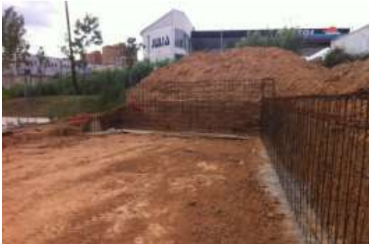
Imagen 6-1.- Armado Muros de contención pista de patinaje. Fuente: http://www.spokoramps.com/es/skateparks/nuestros-skateparks/videos.html . Fecha de consulta Junio 2014.
