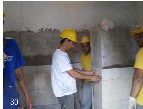
Foto 30. Ejemplo de colocación de azulejo en muros.
