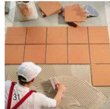
Foto 31. Ejemplo de colocación de vitropiso
