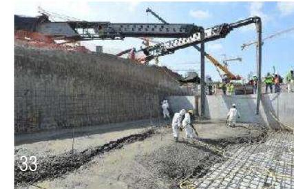
Fotos 32 y 33 ilustra la construcción de firmes de concreto
