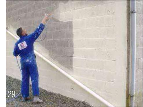
Foto 29, ejemplifica el proceso de sellado en los muros aparentes del proyecto.
