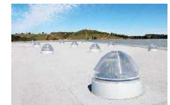
Fotos 53. Ejemplo de solotube ya colocado y funcionando, Foto 54. solotube
