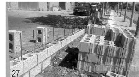
Fotos 26 y 27 Ejemplo de sistemas constructivos de muros de bloq hueco
