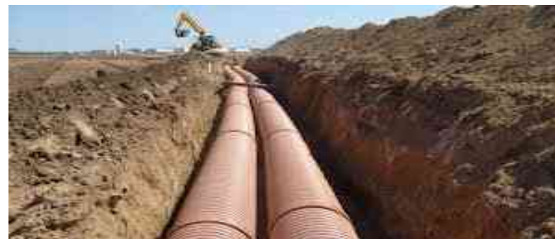
Ilustración 42.- fotografía de obra, colocacion de ductos de drenaje. www.bioaguachile.cl
