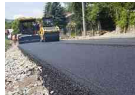
Ilustración 45.- Carpeta asfáltica. http://www.arqhys.com
