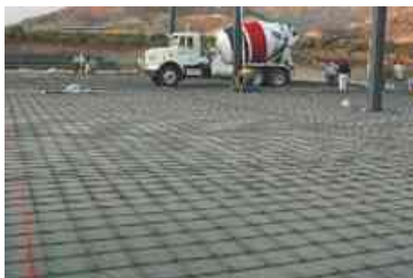
Ilustración 43.- Armado de firme de concreto . http://www.arqhys.com
