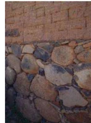
**Figura. -39** Cimentación de la vivienda tradicional de huetamo, donde el cimiento es de piedra brasa asentado con arcilla, para recibir muro adobe de arcilla con medidas de 0.60x.40x.10, corte realizado por el autor con la técnica de tinta.
