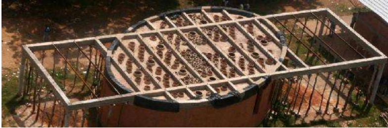
Ilustración 27 Biblioteca Gando. En http://www.kerearchitecture.com/projects/school-library-gando/
