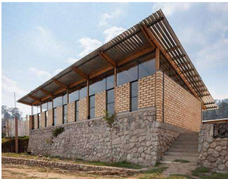
Ilustración 39 Aula Nueva en http://www.plataformaarquitectura.cl
