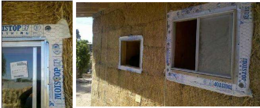
Ilustración 72 y 73 Opción de malla antes del aplanado de tierra. En Mexicali Project 2011. http://casadepaja.org/?q=node/23
