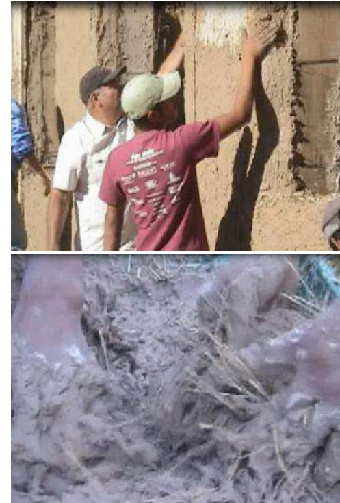
Ilustración 70 y 71 Mezcla y aplanado con barro. En captura de video SEMARNAT, CONAFOR. Tecnologías alternativas para el uso eficiente de recursos . México, 2008.
