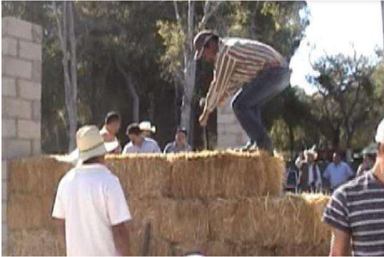
Ilustración 64 Clavado de pacas. En captura de video SEMARNAT, CONAFOR. Tecnologías alternativas para el uso eficiente de recursos. México, 2008.
