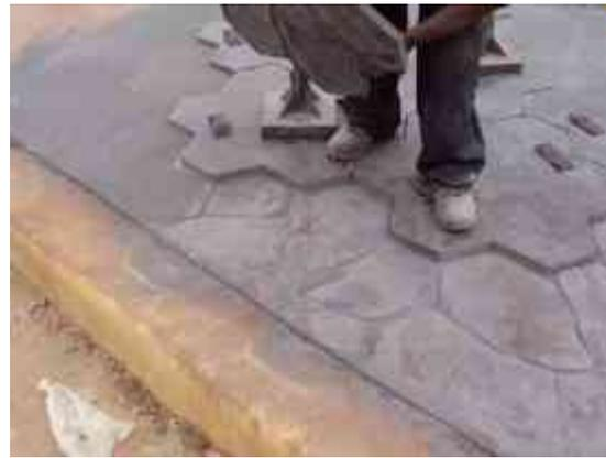
En las imágenes anteriores se muestra el sistema constructivo del concreto estampado, será utilizado en áreas exteriores como vestíbulos, zonas gastronómicas, pasillos de comunicación, plazas, etc. Mientras tanto en el interior de los pabellones se utilizará concreto pulido.
