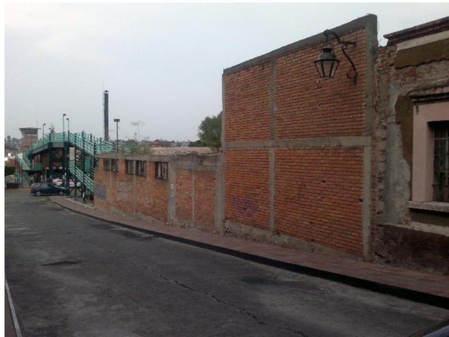
f31. Terreno. Vista poniente.
