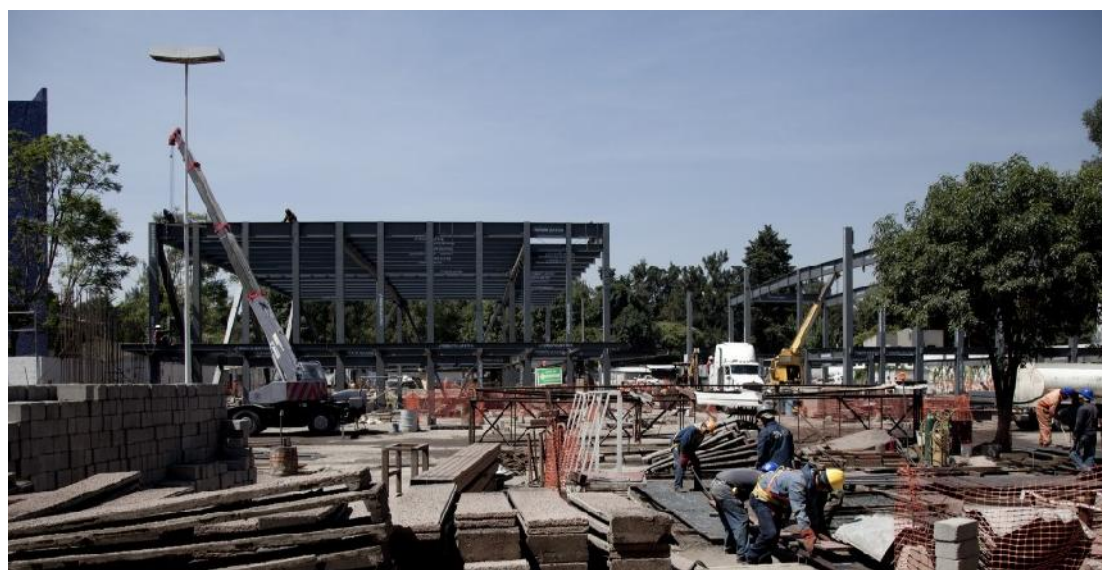
f-50. Estructura de acero. Cineteca Nacional.
