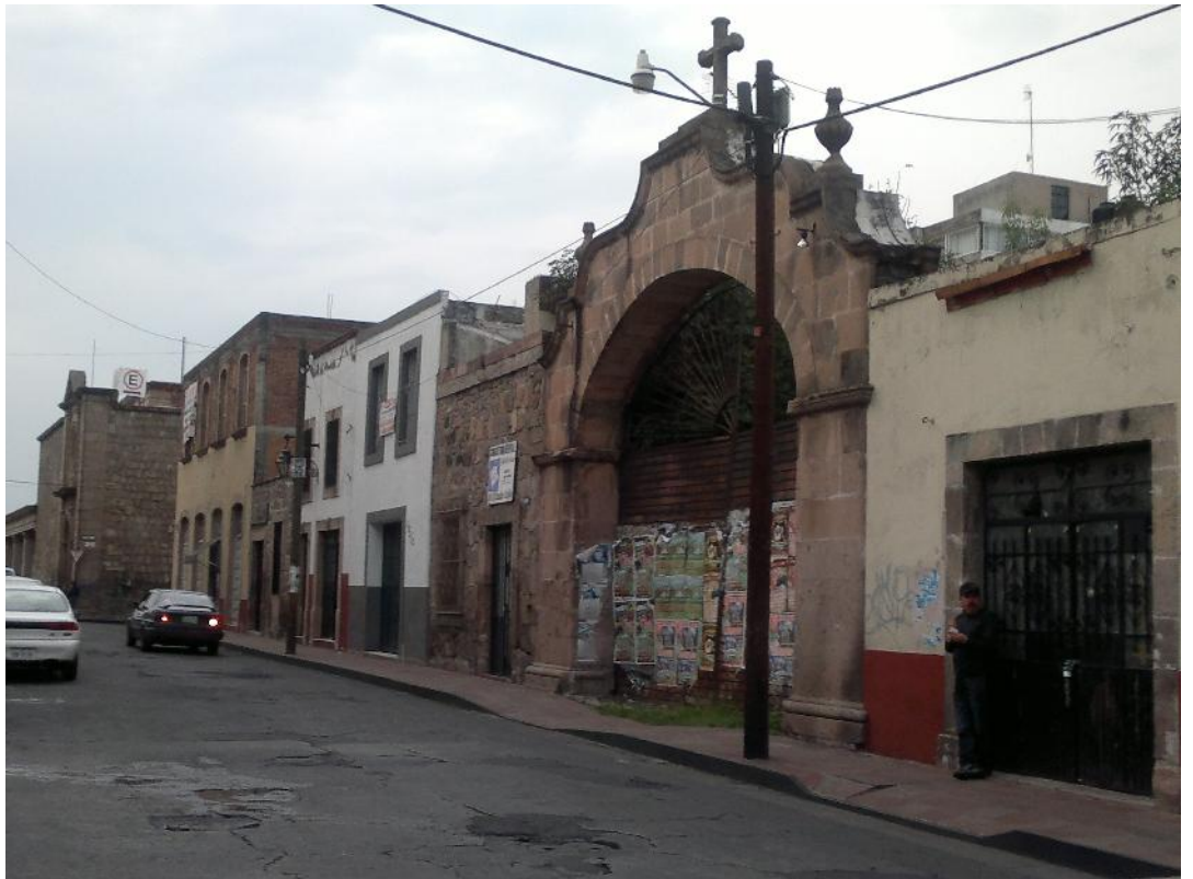
f-30. Fachada calle Eduardo Ruíz.
