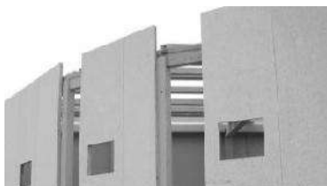
Fig. 45 Panel de Concreto en estructura de acero, fotografía arq.com Elaborado por MAGR
