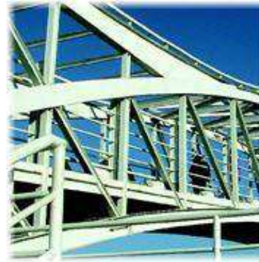
Fig. 56 Estructura de acero de un puente. , Imagen arq.com Elaborado por MAGR
