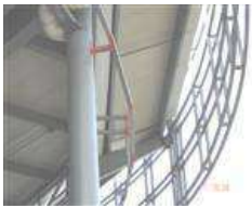
Fig. 52 Forma en que fija la lamina de multitecho en la estructura de acero, Imagen arq.com Elaborado por MAGR
