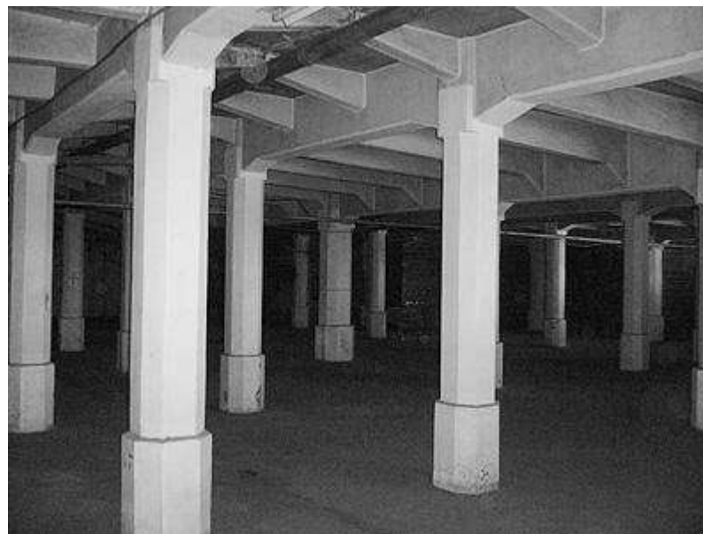
Fig. 52 Estructura de concreto armado, Imagen arq.com Elaborado por MAGR
