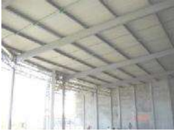
Fig. 53 Forma en que fija la lamina de multitecho en la estructura de acero, Imagen arq.com Elaborado por MAGR
