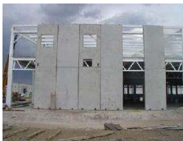
Fig. 44 Colocación de panel de Concreto en estructura de acero, fotografía arq.com Elaborado por MAGR
