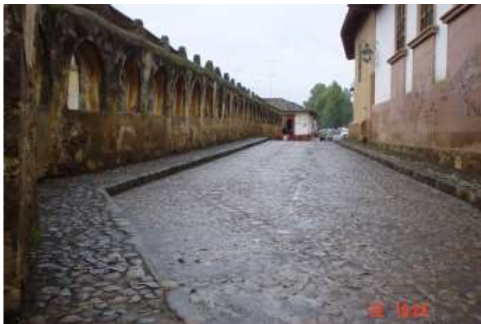
Imagen 100 : Construcción de banquetas en la calle Lerín, año 2003. Fuente: archivo personal Noel Rodríguez Romero
