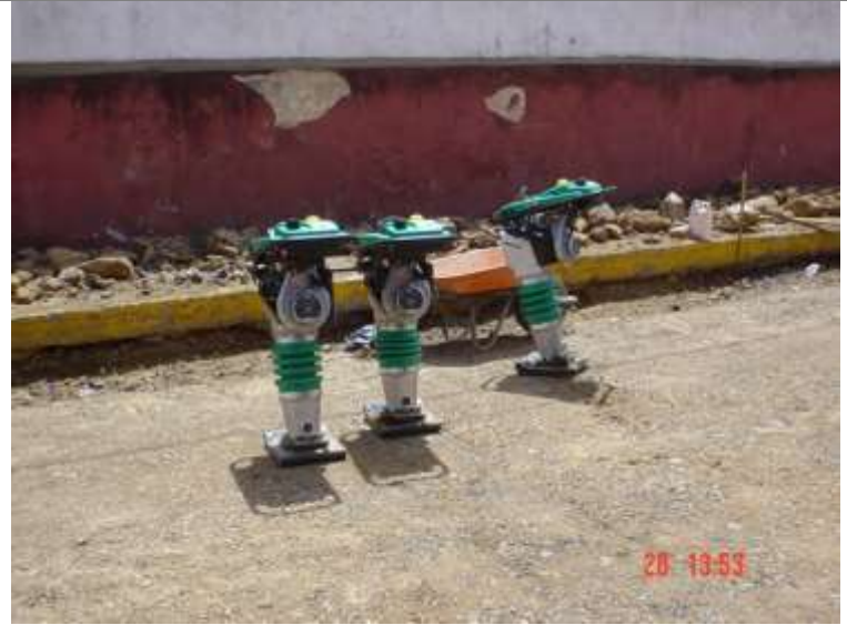
Imagen 59 : Compactación de terracerías calle Terán.. 2003 Fuente: Archivo personal Noel Rodríguez Romero.
