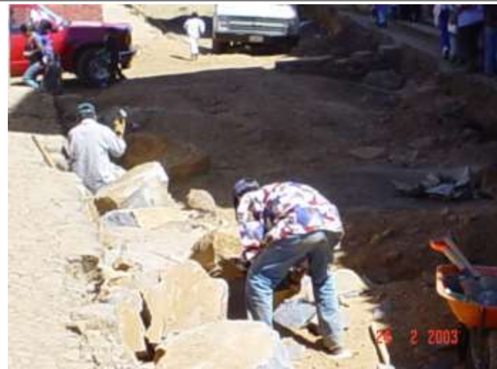
Imagen 47 : Instalación de red pluvial en la calle enseñanza. Año 2003 Fuente: Archivo personal Noel Rodríguez Romero.
