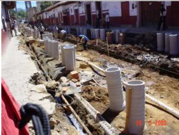
Imagen 38 : Instalación de colector pluvial en calle Árciga. Año 2003 Fuente: archivo personal Noel Rodríguez Romero
