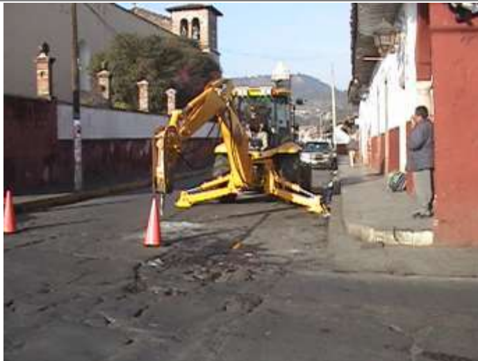
Imagen 30 : Demolición de empedrados en la calle enseñanza. Fuente: archivo personal Noel Rodríguez Romero
