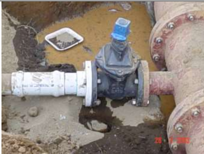
Imagen 50 : Válvula de seccionamiento de agua potable Fuente: archivo personal Noel Rodríguez Romero
