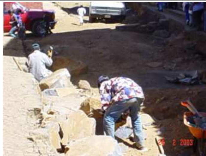
Imagen 39 : Instalación de red pluvial en la calle enseñanza. Año 2003 Fuente: Archivo personal Noel Rodríguez Romero.
