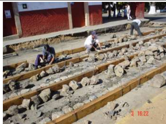
Imagen 67 : Tendido de cadenas de piedra. Trabajos nocturnos. Calle Enseñanza. Año 2003 Fuente: Archivo personal Noel Rodríguez Romero.
