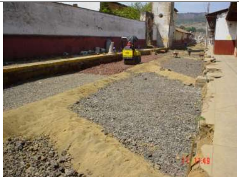
Imagen 61 : Terracerías y compactación. Calle Terán año 2003. Fuente: archivo personal Noel Rodríguez Romero
