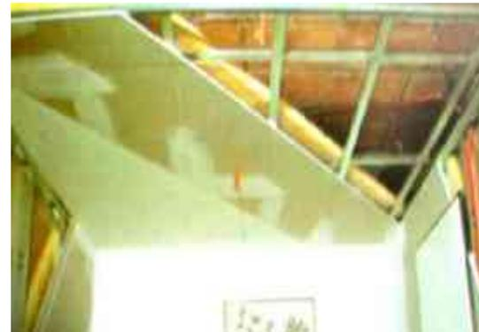
**Imagen 080:**(Plafón) en esta figura se muestran la colocación del plafón o techo falso suspendido, así como su recubrimiento también llamado acabado aislante.
