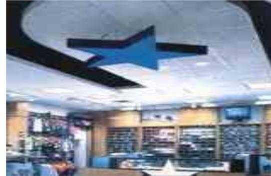
**Imagen 079:** en la figura se muestra el plafón suspendido formado con placas de materiales diversos
