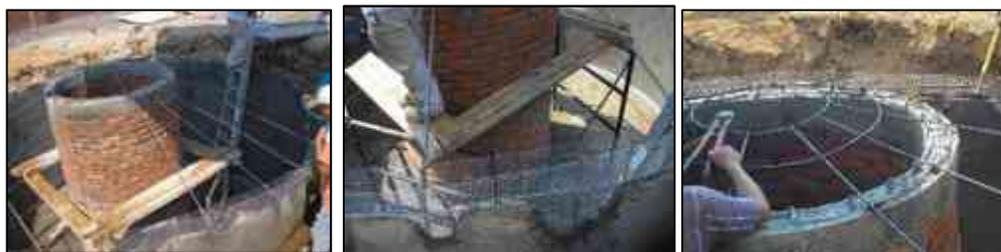
Imagen 75. Proceso de construcción de cisterna. Fuente: cisternas de ferrocemento. <http://www.bosquedeniebla.com.mx/eco05>. 25/03/2014
