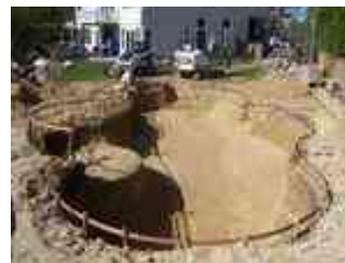
Imagen 81. Construcción de una piscina natural. Fuente: BioNova natural pool, Precios de piscinas naturales, <http://www.bionovapiscinasnaturales.com/gama-de-piscinas/precios/>, 05/04/2014.
