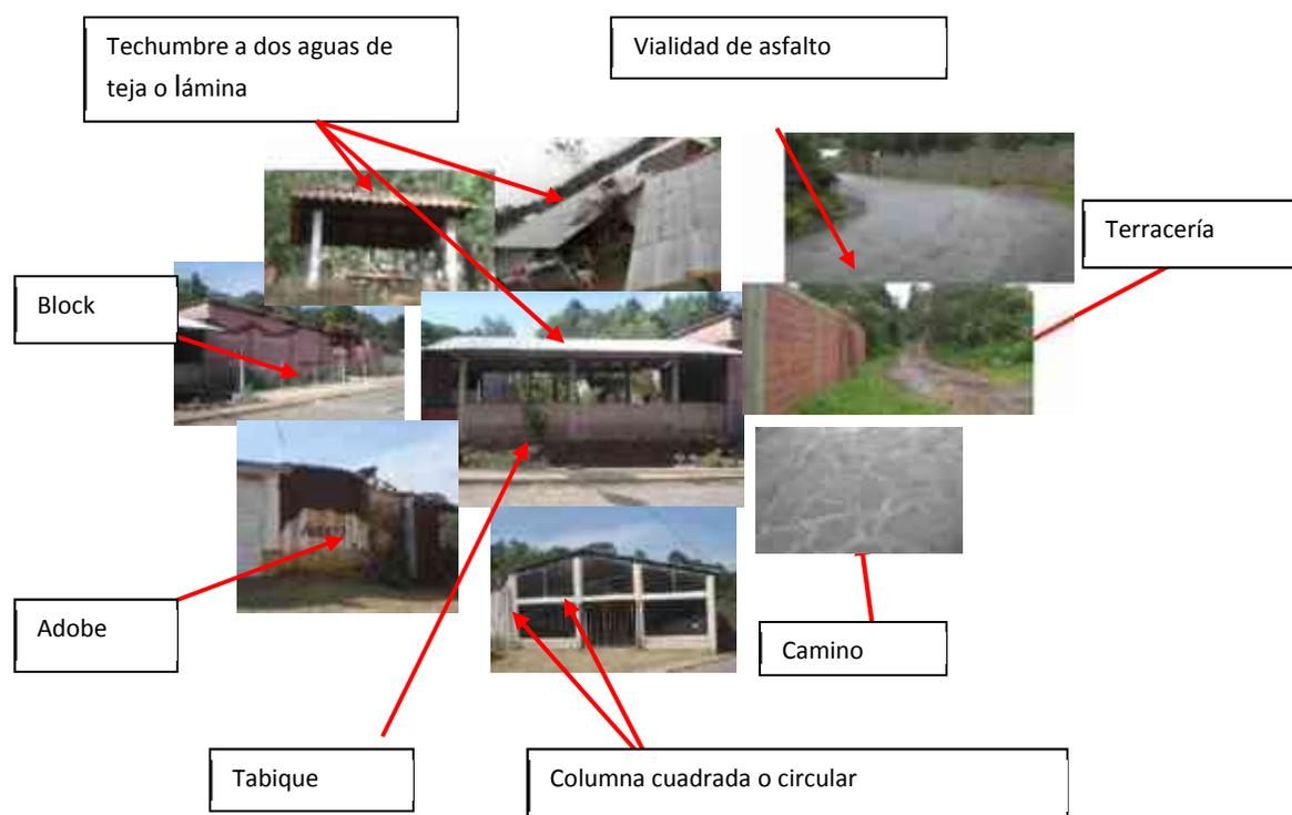
En conclusión, la tipología que rige en el lugar son los techos a dos aguas de teja, estructura de tabique, con soporte a base de columnas cuadradas de madera o concreto, a últimas fechas se observa el empleo del block en la construcción. Esta tipología será utilizada como base en el proyecto en cuanto a materiales y sistemas constructivos se refiere.
