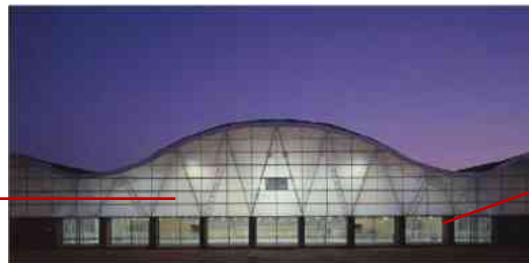
Imagen 27.-POLIDEPORTIVO EN PALAFOLLS-FACHADA
