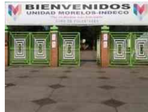
Imagen 5.-UNIDAD DEPORTIVA-INDECO, FACHADA PRINCIPAL
