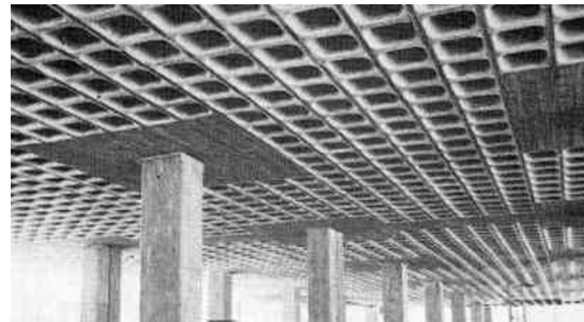
Imagen 56.-Vista de Losa Reticular
