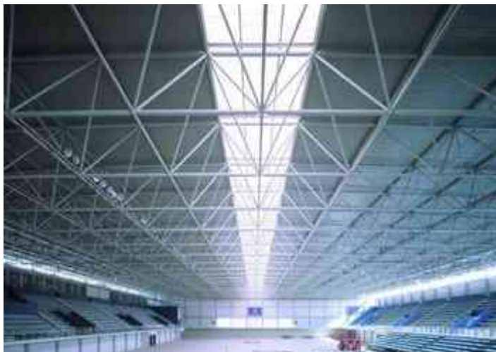
Imagen 55.-Vista de sistema de Tridilosa Metálica.
