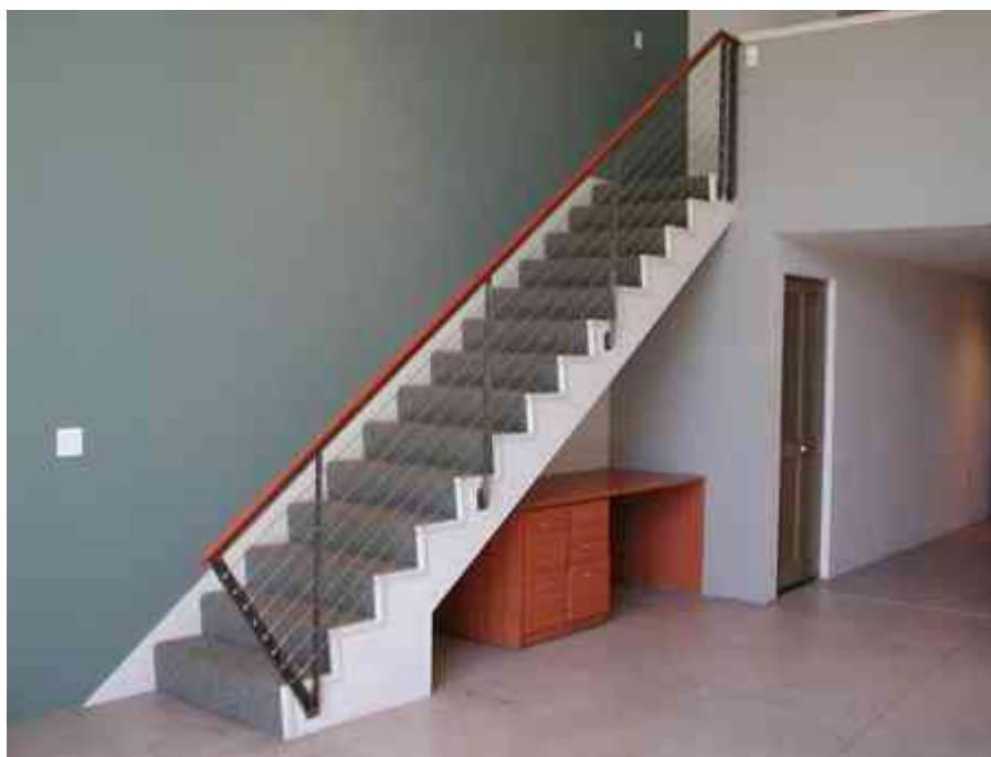
Imagen 48. Railing fabricado con material sólido, con sistema de cables que permiten cerrar el espacio a menos de 4".
