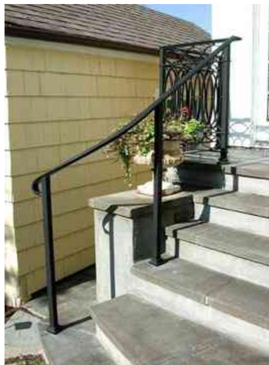
Imagen 61. Pasamano de molding prefabricado y postes de tubo, que están incrustados en el piso mediante bases de metal prefabricadas empleadas para cubrir la perforación del piso.
