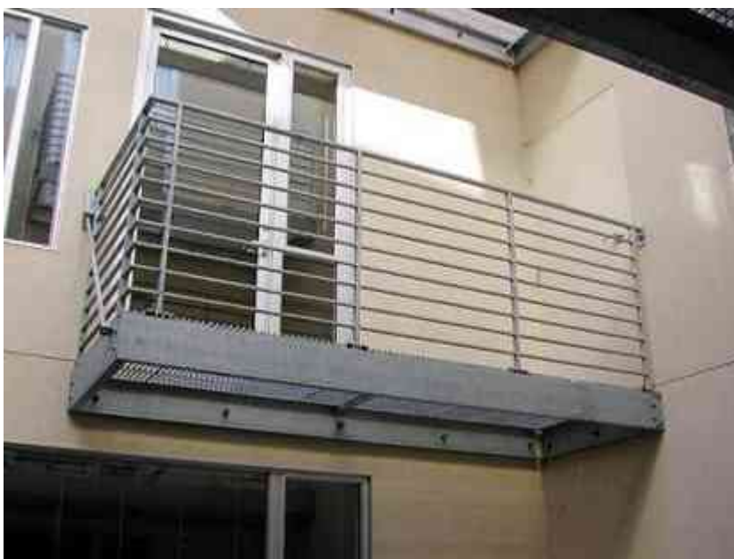
Imagen 81. Balcón formado con estructura de canal y piso de grating (rejilla) con un tensor, en uno de los costados, que permite reforzar la esquina en cantiléver.
