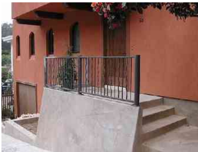
Imagen 55 (Arriba). Guardrail con pickets de barra sólida doblada.
