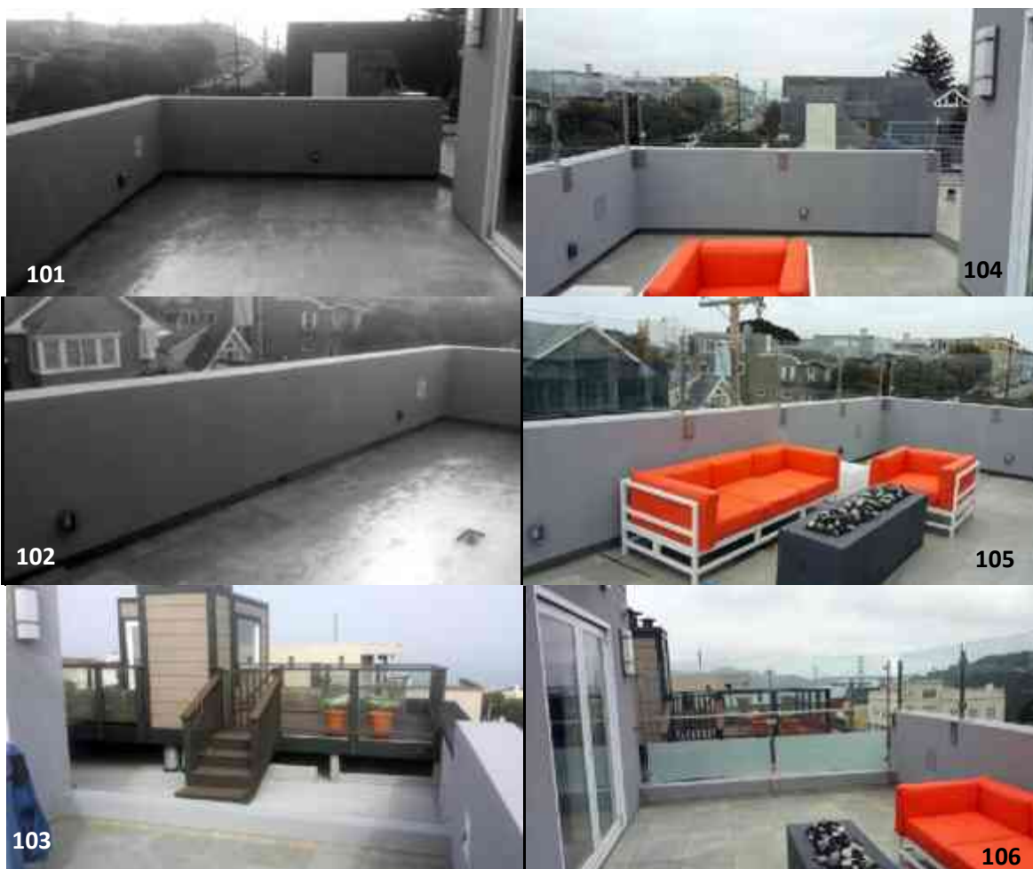
Imagen 101-103. Vivienda ubicada en 111 27th Avenue, San Francisco CA/ Sitio de colocación del windscreen, antes del trabajo realizado.
