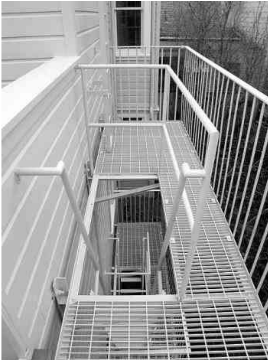
Imagen 30. Guardrails de protección en el perímetro del balcón y hueco de la escalera.
