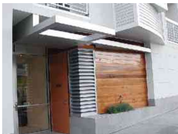
Imagen 90. Canopy fabricado con material tubular para jerarquizar el acceso principal.
