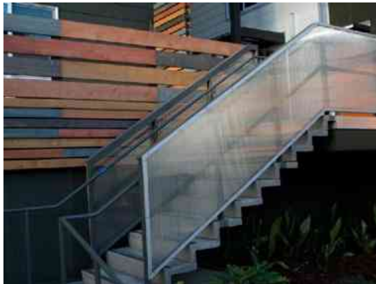
Imagen 37 (Arriba). Guardrail fabricado con material sólido y slats de metal de 1/8" de grueso, para cerrar el espacio a menos de 4". Imagen 38 (Abajo). Guardrail fabricado con material tubular y paneles de policarbonato para cerrar el espacio a menos de 4".
