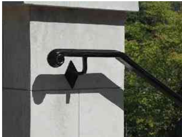
Imagen 62. Pasamanos de molding prefabricado con terminación de voluta, sujeto al muro con una bracket formada con un standoff, hecho de barra cuadrada sólida de ½", y una placa en forma de rombo.
