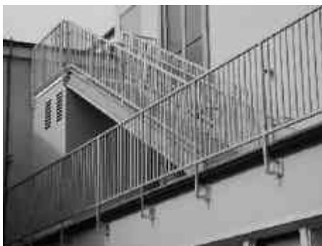
Imagen 51. Guardrail y Railing fabricado con material tubular.
