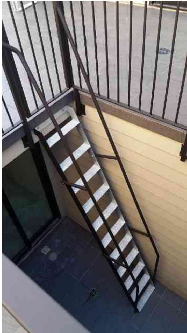
Imagen 31. Connecting ladder, para la vivienda ubicada en 39 San Carlos Street, Ca.
