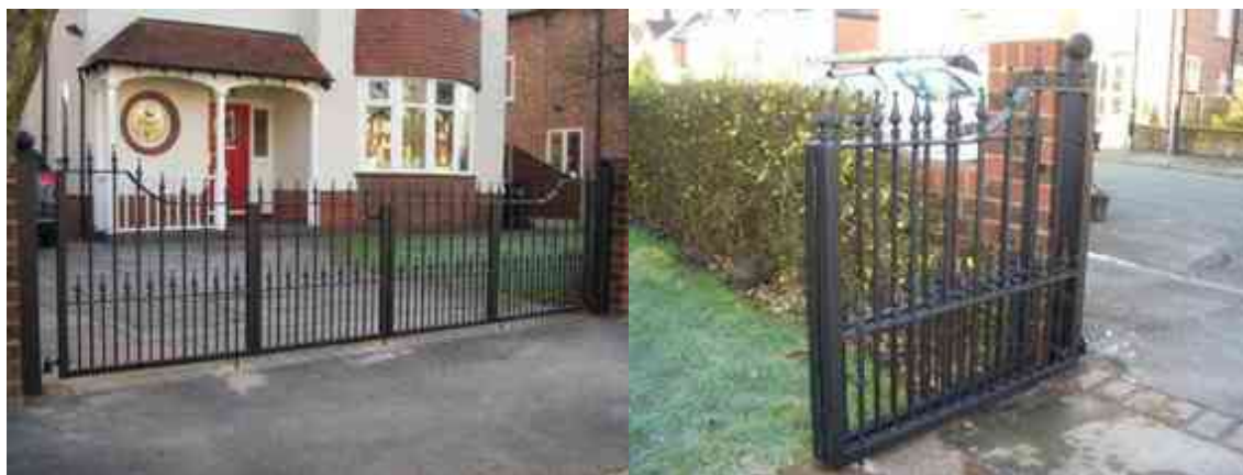
Imagen 72 (Superior Izquierda). Puerta en acordeón que se encuentra cerrada. Imagen 73 (Superior Derecha) Puerta en acordeón con ambas hojas plegadas, de forma paralela, entre sí.
