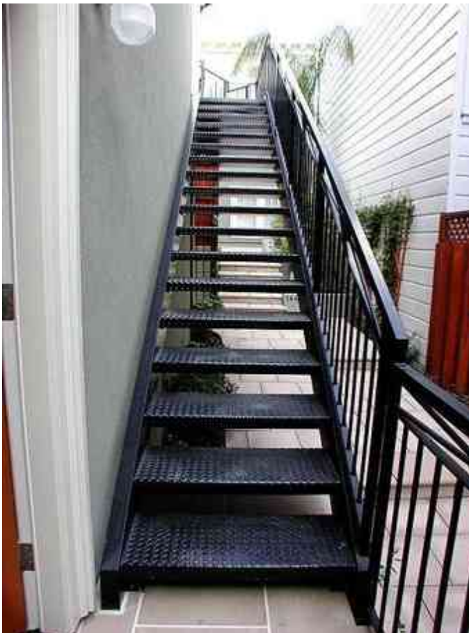
Imagen 15. Escalera de un solo flight (vuelo) con doble stringer (languero), de canal, y escalones open riser (peralte abierto), formados con checkered plate (placa con textura de diamante), soldados a los stringers (langueros).
