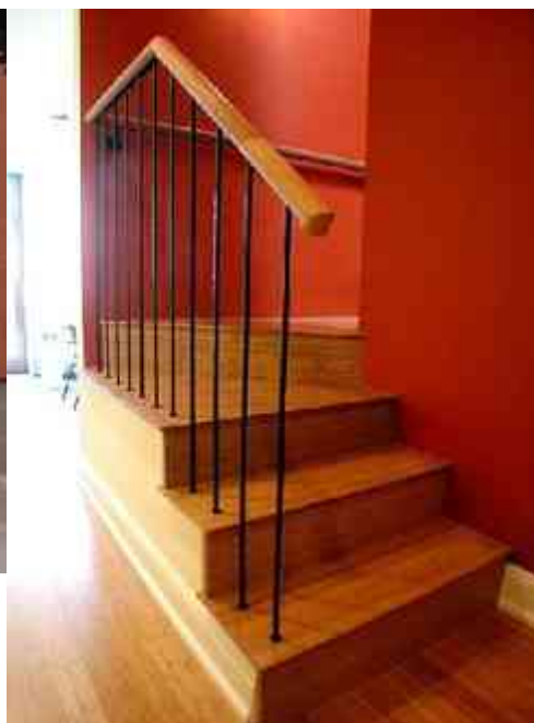
Imagen 56 (Derecha) Railing con pickets de barra sólida circular, los cuales se incrustan en el piso (de 3" a 4").
