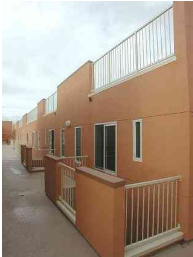
Imagen 35. Guardrail con pickets de barra de ½" de diámetro, sujeto a la construcción por los costados.
