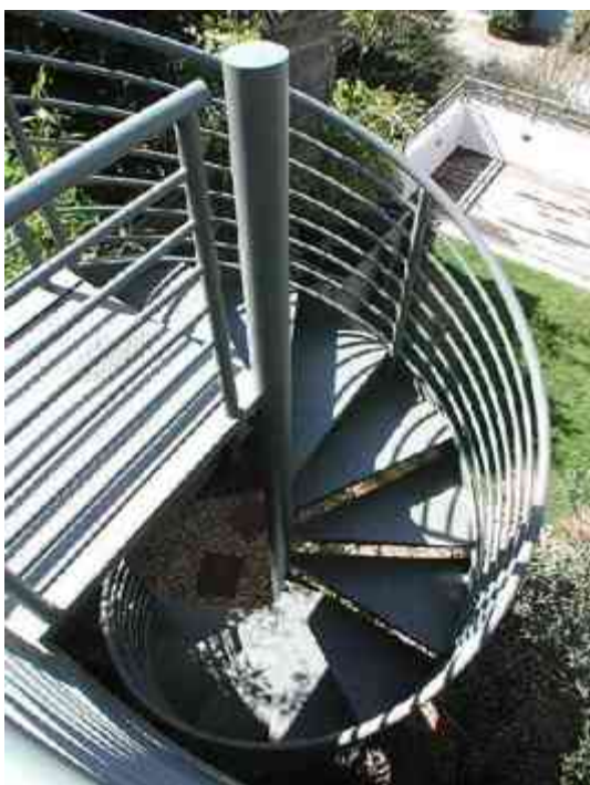
Imagen 21. Escalera en espiral, con escalones y landing de \frac{1}{8} " checkered plate (textura de diamante)
