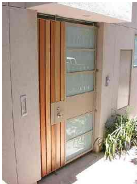
Imagen 68. Puerta de acceso peatonal fabricada con material sólido (ángulos y soleras), slats de madera y paneles de cristal.
