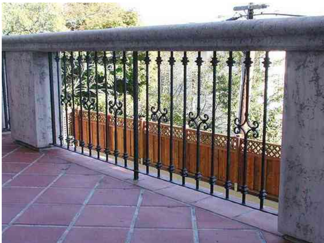
Imagen 57 (Abajo). Guardrail con hammered posts (postes martillados) y pickets de barra sólida con diseño en la parte central y collares en ambos extremos.
