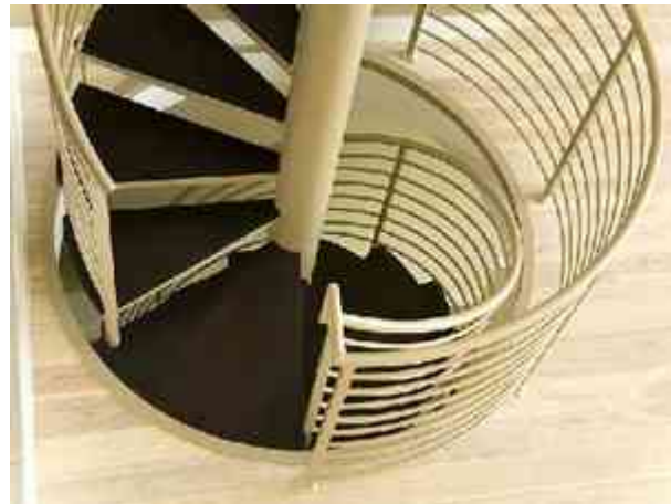
Imagen 24 (Izquierda) y 25 (Derecha). Escalera en espiral desarrollada a partir de una abertura en el piso de forma circular, con un guardrail siguiendo la misma forma del hueco de la escalera para evitar una caída.
