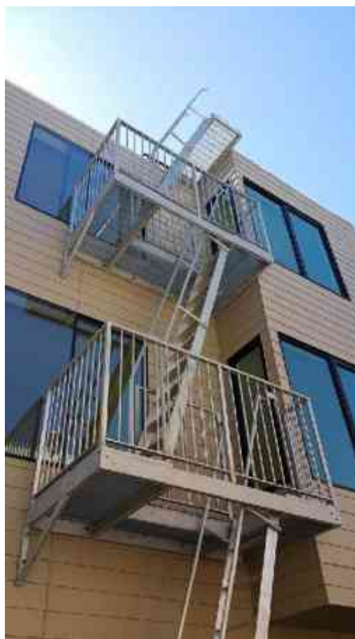
Imagen 26. Fire escape en el edificio de departamentos ubicado en 39 San Carlos Street, con balcones en cada uno de los niveles de la construcción, fabricados con canales C 5 x 6.7 y grating formado con barras de \frac{1}{8} " x 1" a cada 1\frac{3}{16} " unidas entre sí con una barra sólida redonda de 4".
