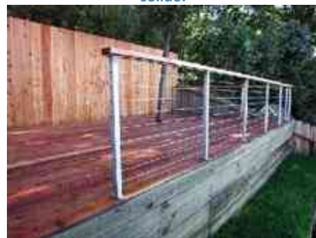
Imagen 54. Guardrail fabricado con material tubular y sistema de cables, que permiten cerrar el espacio a menos de 4".
