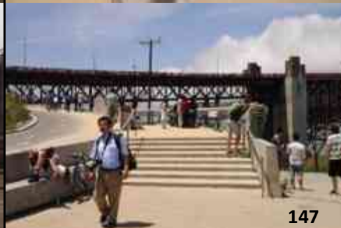
Imagen 145-147. Paradero turístico "Golden Gate Bridge Overlook" / Handrails, después del trabajo realizado.
