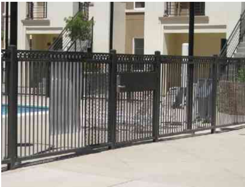
Imagen 76. Defensa fabricada con material tubular con postes incrustados en el piso de concreto y para los pickets (barros verticales), material sólido.
