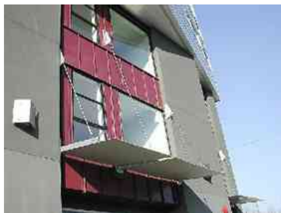
Imagen 89. Canopy fabricado con ángulos fijos a la estructura mediante placas de conexión y un sistema de tensores para soportar el cantiléver; estos ángulos reciben unos paneles de policarbonato.
