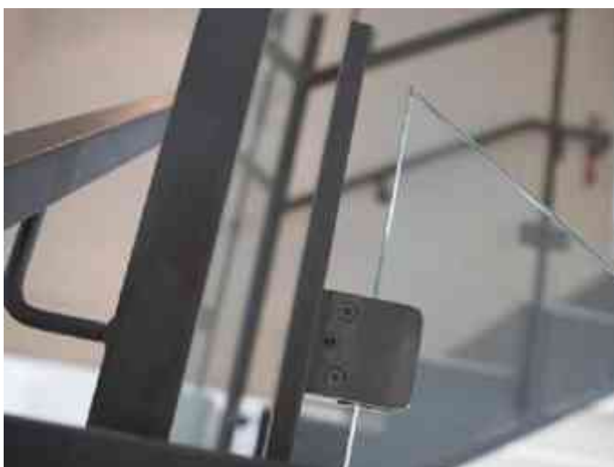
Imagen 43 (Arriba). Clamp atornillada a la estructura del railing que permite recibir el panel de cristal. Imagen 44 (Abajo). Guardrail con paneles de cristal sujetos mediante clamps.
