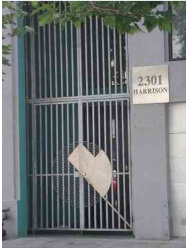
Imagen 65. Puerta abatible de acceso peatonal fabricada con material tubular.
