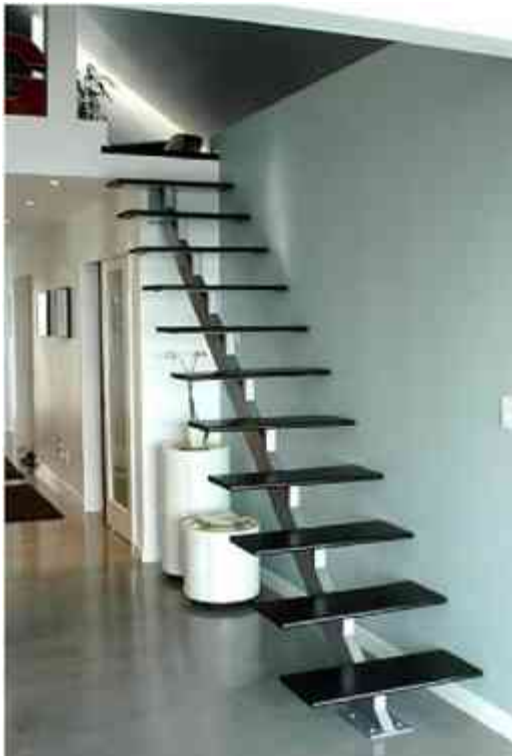
Imagen 12 (Izquierda). Escalera con un solo stringer (larguero), de material tubular sección rectangular, sujeto en la parte inferior y superior con una placa y cuatro tornillos. Los escalones son de madera, soportados por standoffs (espaciadores), de tubo cuadrado, soldados a los stringers y a una placa de sujeción, que permite atornillar por debajo los escalones que se encuentran en cantiliver en ambos extremos. Imagen 13 (Derecha). Escalera con un solo stringer (larguero), sujeto con una placa de conexión y 4 tornillos en la parte inferior y varios tornillos en el muro; el stringer es de material tubular con resacos para permitir la instalación de escalones y landing de madera con un extremo en cantiliver.
