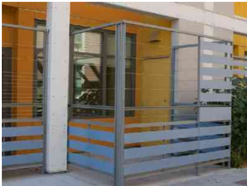
Imagen 79. Defensa fabricada con material sólido (ángulos) con slats de metal (placas de \frac{1}{4} " de grueso) y cables de \frac{1}{2} " de diámetro.
