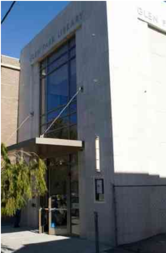
Imagen 84. (Izquierda) Canopy formado con una estructura de canal, cubierta con lámina de aluminio; también se utilizó un sistema de tensores para brindar mayor soporte a las esquinas en cantiléver.
