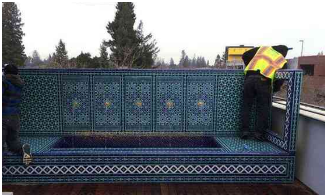
Imagen 92. Fountain (Fuente) fabricada con estructura tubular de acero inoxidable, recubierta con una hoja de metal liso y expanded metal (lámina de metal expandido) para recibir el mortero que pega el azulejo.
