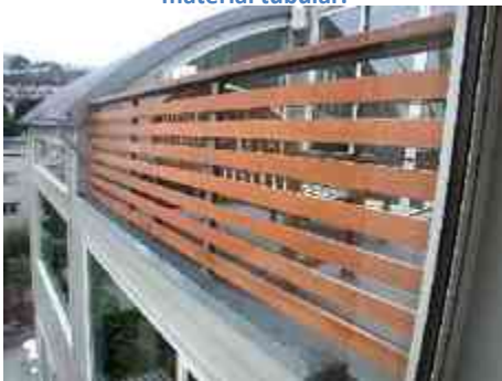
Imagen 53. Guardrail fabricado con material tubular y slats de madera, para cerrar el espacio a menos de 4".
