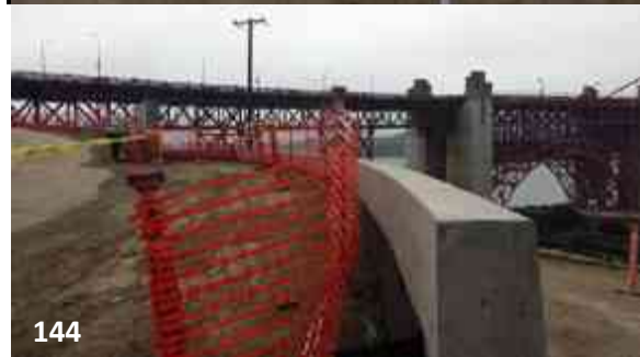
Imagen 142-144. Paradero turístico "Golden Gate Bridge Overlook" / Escalera de concreto, antes de la colocación de los handrails (pasamanos).
