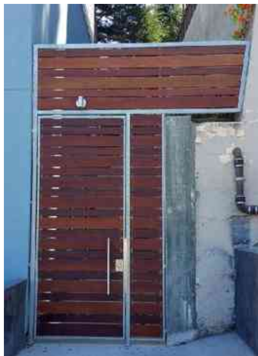
Imagen 67. Puerta de acceso peatonal fabricada con material tubular y slats de madera.
