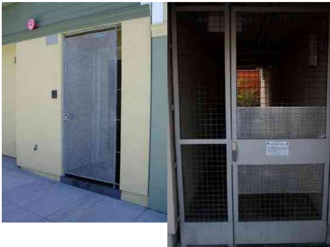
Imagen 74 (Inferior Izquierda). Puerta abatible de acceso principal, fabricada con material sólido y lámina perforada. Imagen 75 (Inferior Derecha). Puerta abatible fabricada con material tubular y paneles de malla.
