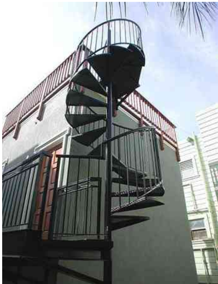
Imagen 23. Escalera en espiral con una bracket en escuadra formada con ángulo para atrapar la esquina en cantiléver del landing superior. También se observa un refuerzo de ángulo por debajo del landing inferior para conectar la columna a la estructura del edificio.
