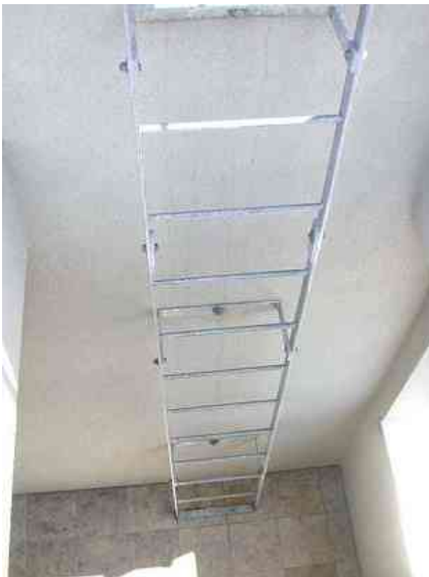
Imagen 32. Pitt Ladder fija a la pared con un soporte en forma de "U", hecho con solera de \frac{1}{2} " x 2", con 1 tornillo. (En escaleras de gran altura es recomendable utilizar al menos 2 tornillos por cada soporte.
