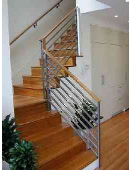
Imagen 49 (Arriba). Railing fabricado con material tubular y un cap rail de madera, atornillado al top rail del railing.
