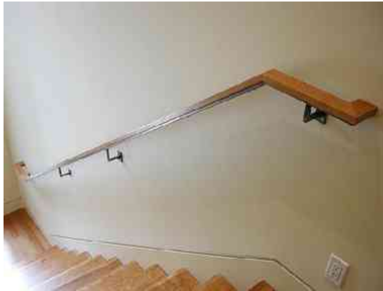
Imagen 59. Pasamano fabricado con la combinación de solera a la que se atornilla un cap rail de madera.
