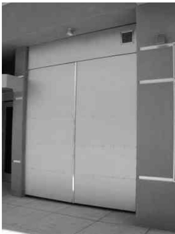
Imagen 66. Puerta de acceso peatonal fabricada con material tubular y paneles de metal, atornillados a la estructura de la puerta.
