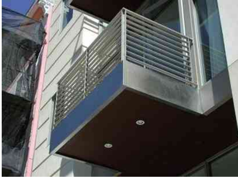
Imagen 80. Balcón formado con estructura de canal recubierto, por la parte inferior, con madera.
