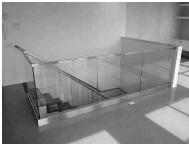
Imagen 47 Canal de aluminio utilizado para recibir los paneles de cristal de ½" de grueso.
