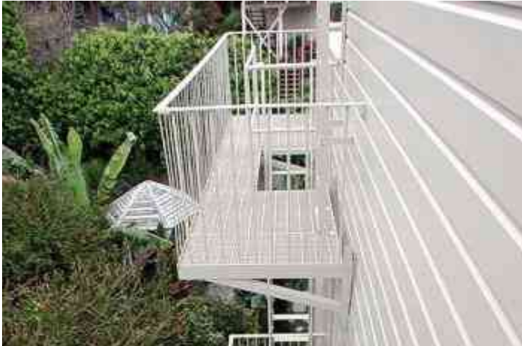
Imagen 28. Balcón con soportes en escuadra, hechos de ángulo, para transmitir las cargas al edificio.
