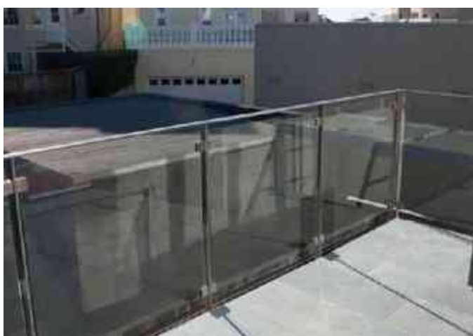
Imagen 43 (Arriba). Clamp atornillada a la estructura del railing que permite recibir el panel de cristal. Imagen 44 (Abajo). Guardrail con paneles de cristal sujetos mediante clamps.
