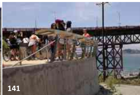
Imagen 141. Paradero turístico "Golden Gate Bridge Overlook" / Solid Round Bars Guardrail, después del trabajo realizado.
