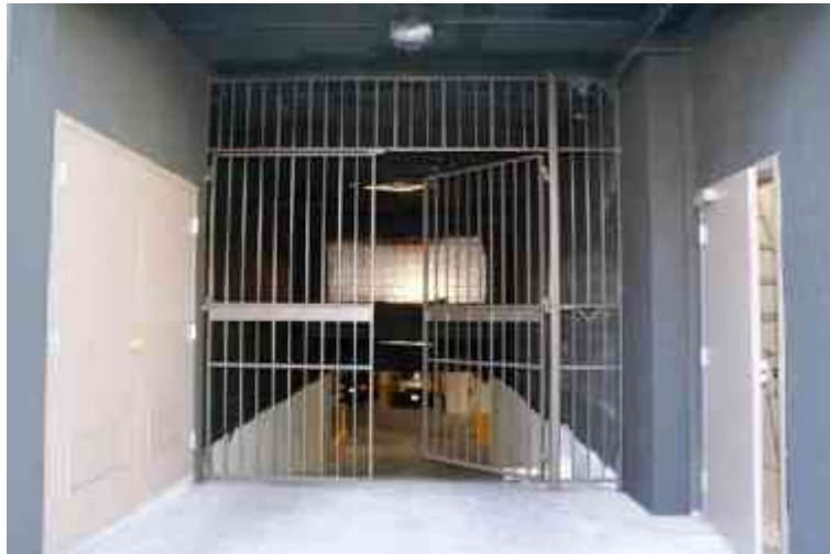
Imagen 64. Puerta de dos hojas abatibles, fabricada con material tubular y pickets de material sólido, que da acceso a un estacionamiento subterráneo.
