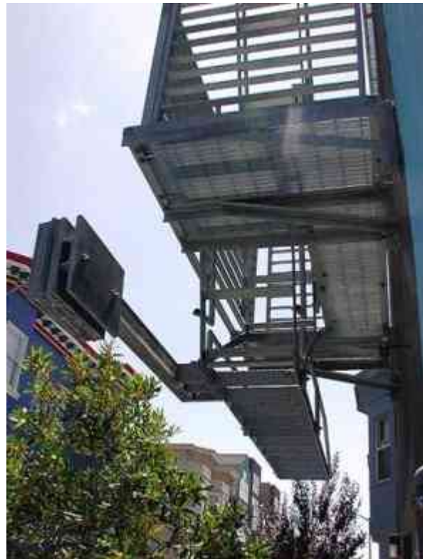
Imagen 27. Fireescape ubicada en la fachada principal del edificio, para permitir el desalojo de los usuarios directamente hacia la vía pública, mediante una escalera plegable contra la estructura del balcón en el primer piso.
