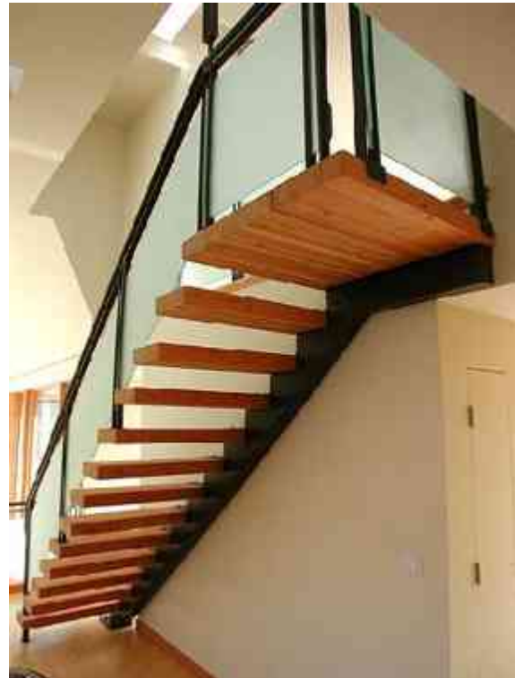
Imagen 12 (Izquierda). Escalera con un solo stringer (larguero), de material tubular sección rectangular, sujeto en la parte inferior y superior con una placa y cuatro tornillos. Los escalones son de madera, soportados por standoffs (espaciadores), de tubo cuadrado, soldados a los stringers y a una placa de sujeción, que permite atornillar por debajo los escalones que se encuentran en cantiliver en ambos extremos. Imagen 13 (Derecha). Escalera con un solo stringer (larguero), sujeto con una placa de conexión y 4 tornillos en la parte inferior y varios tornillos en el muro; el stringer es de material tubular con resacos para permitir la instalación de escalones y landing de madera con un extremo en cantiliver.
