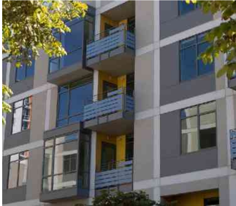
Imagen 37 (Arriba). Guardrail fabricado con material sólido y slats de metal de 1/8" de grueso, para cerrar el espacio a menos de 4". Imagen 38 (Abajo). Guardrail fabricado con material tubular y paneles de policarbonato para cerrar el espacio a menos de 4".
