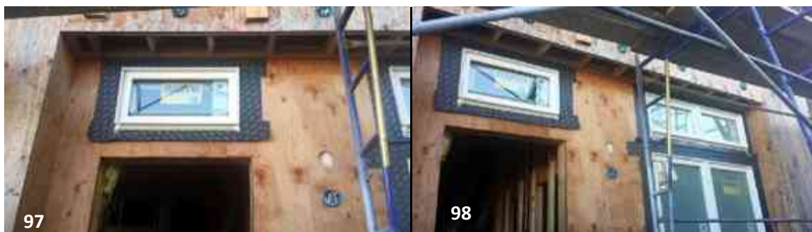
Imagen 97-98. Vivienda ubicada en 4515 20th Street, San Francisco CA/ Sitio de colocación del canopy, antes del trabajo realizado.
