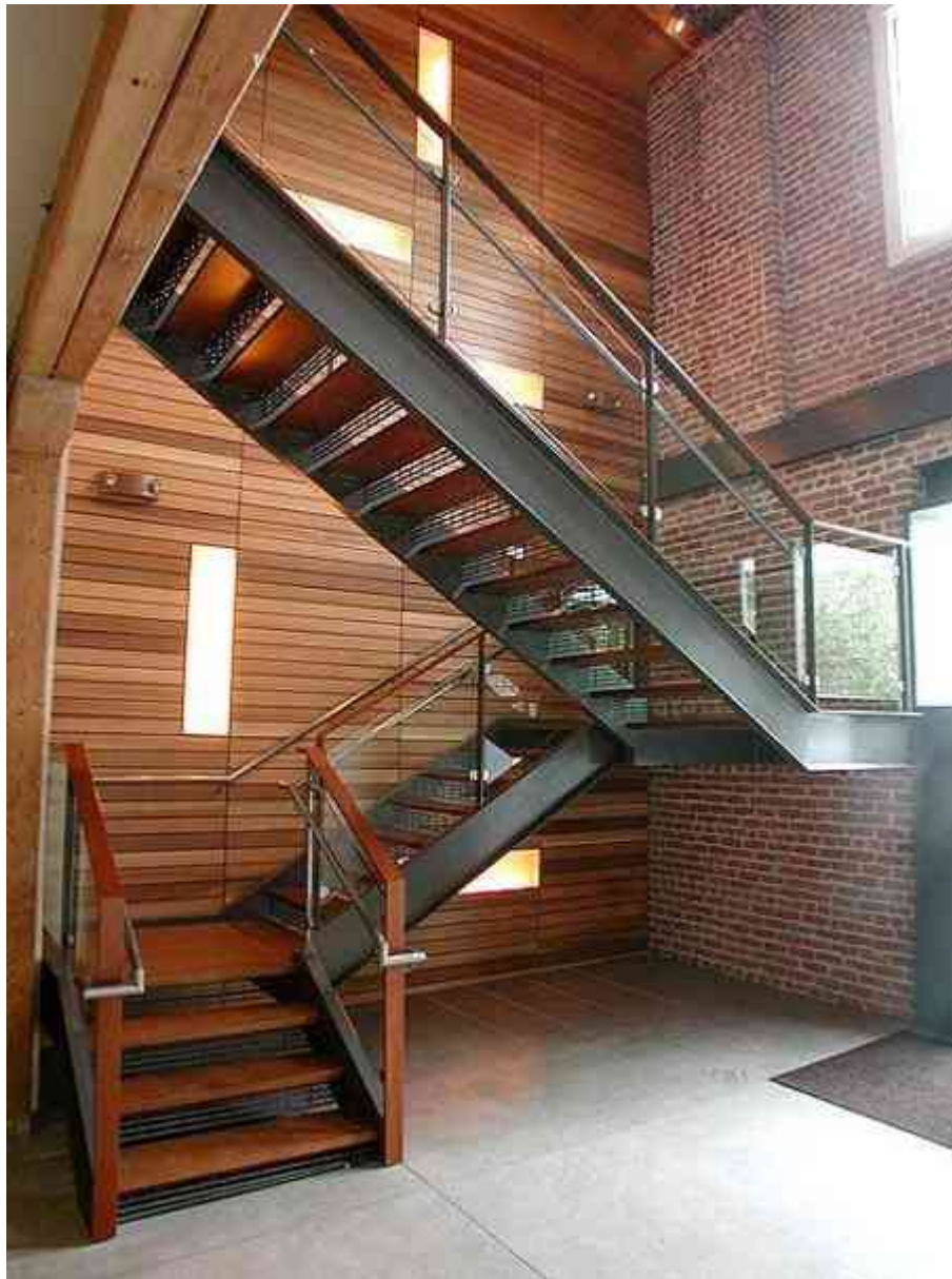
Imagen 14. Escalera desarrollada en varios flights (vuelos) con doble stringer de canal, los cuales se unen con una solera de \frac{1}{2} " de grueso para ser recubiertos con madera posteriormente y dar el terminado final al escalón.
