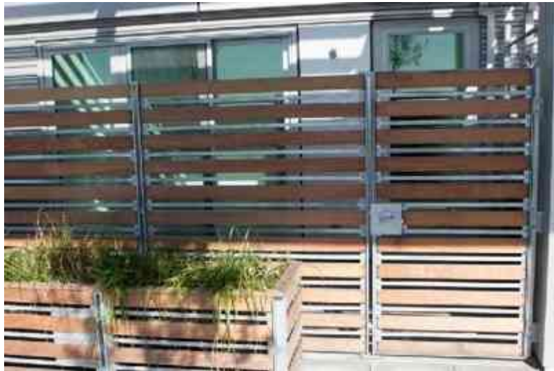
Imagen 78. Defensa fabricada con material sólido (ángulos) y slats de madera.
