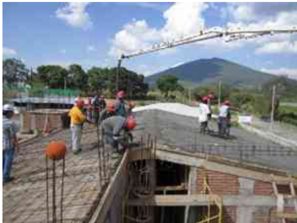
Fig. 42 - Proceso de colado de losa maciza a dos aguas.
