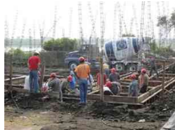
Fig. 27 - Colado de Zapatas corridas.
