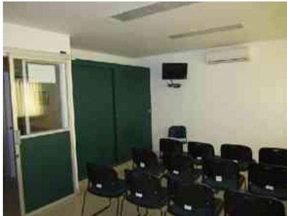
Fig.124 - Instalación de Mini Split en sala de usos múltiples.
