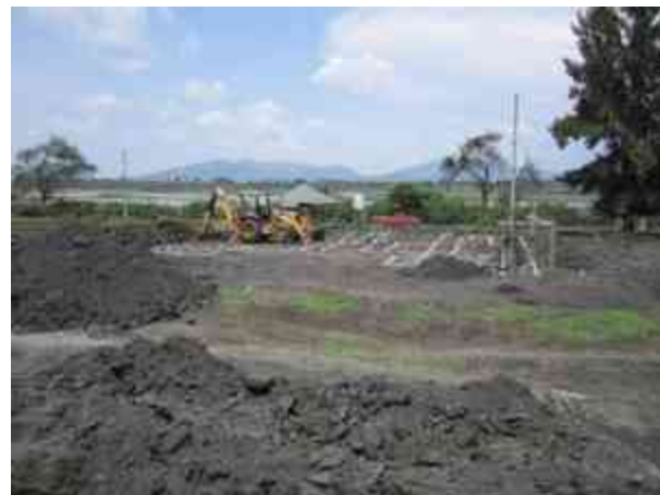
Fig. 21 - Preparación en terreno para zapatas corridas.
