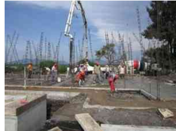
Fig. 33 - Colado de firme, mediante bombeo de concreto.
