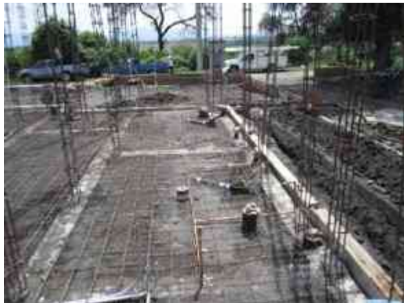
Fig. 94 - Tubería para alimentación de servicios sanitarios y cocina.
