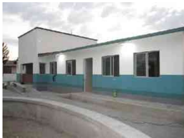
Fig.112 - Luminarias en fachada principal de la unidad.
