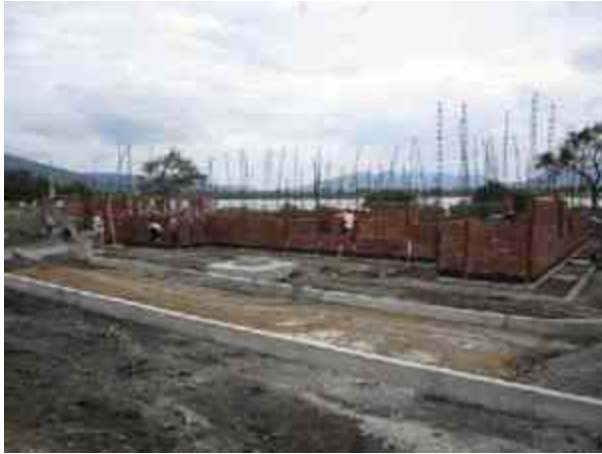
Fig. 36 - Muro forjado a base de tabique rojo.
