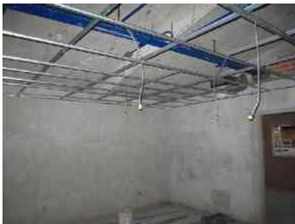
Fig.76 - Bastidor de metal para recibir paneles de yeso, respetando huecos donde habrá luminaria.
