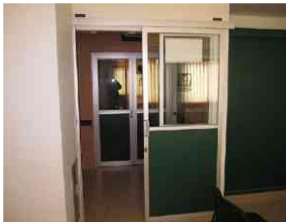
Fig. 59 - Cancel corredizo terminado de Sala de Usos Múltiples.
