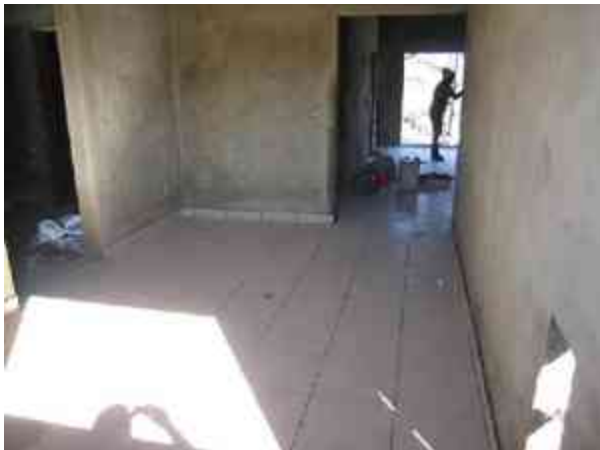
Fig. 46 Colocación de Zoclo de 30x10 cms.
