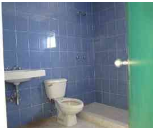
Fig. 70 - Colocación de inodoro y lavabo baño residencia.
