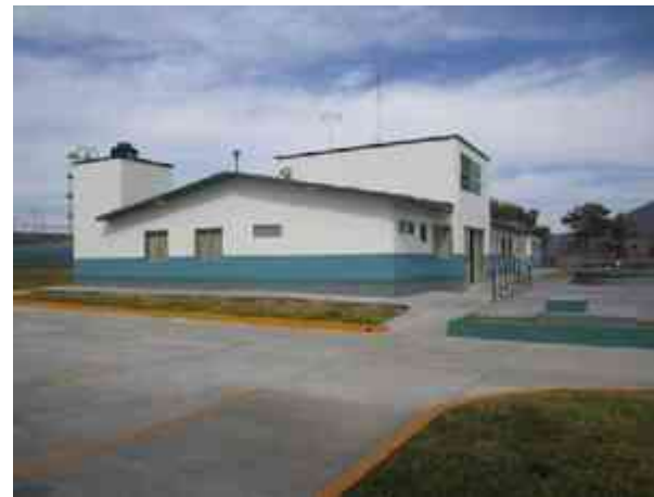
Fig. 167 - Fachada lateral de la Unidad.
