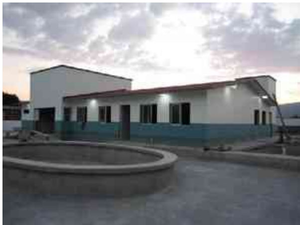
Fig. 52 - Colocación de ventanearía de aluminio color natural en exterior.
