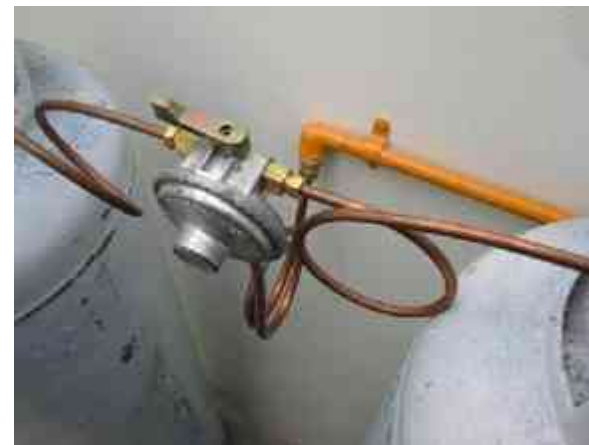
Fig.117 - Regulador de flujo de gas.
