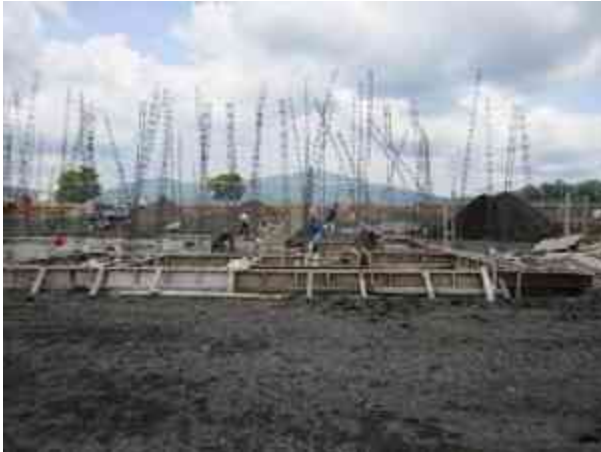
Fig. 24 - Cimbrado a base de bastidor de triplay para colado de Zapatas.
