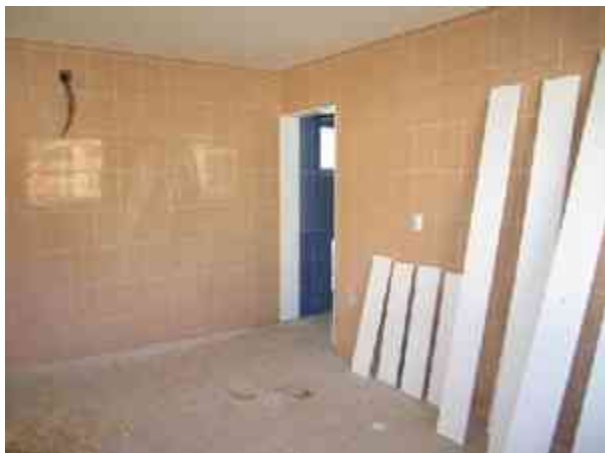
Fig. 60 - Colocación y habilitado de chambrana metálica de lamina negra cal.18, y pintura electroestática color blanco.
