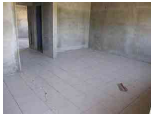
Fig. 49 - Colocación de loseta cerámica sobre firme de concreto, color beige de 30x30 cms, en Sala de Usos Múltiples.
