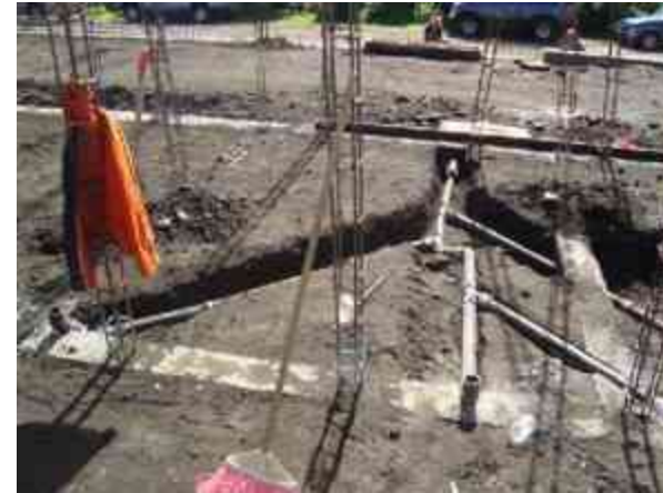
Fig. 87 - Descarga del área de Medicina preventiva y rehidratación oral.
