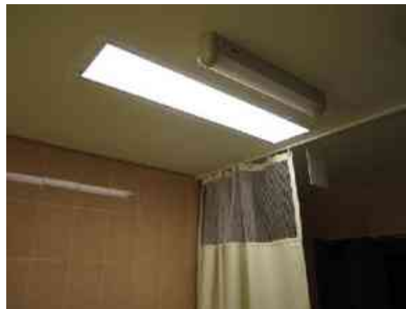
Fig. 111 - Instalación de luminaria de circuito normal y luminaria de emergencia, área de recuperación.
