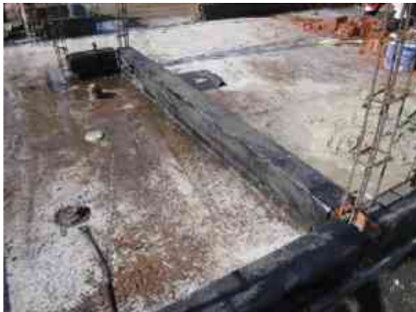
Fig. 34 - Desplante de tabique sobre el firme de concreto para conformar muros.
