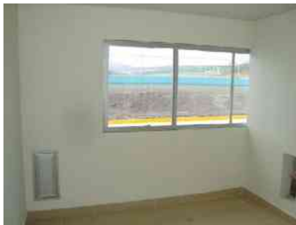
Fig. 56 - Ventana de Exploración, Farmacia y Archivo, a base de aluminio serie bolsa 2000 y cristal flotado.
