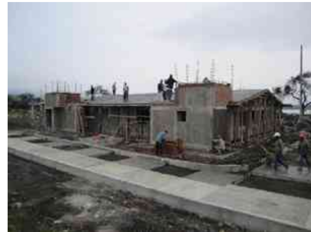
Fig. 43 - Colado de losa a dos aguas.
