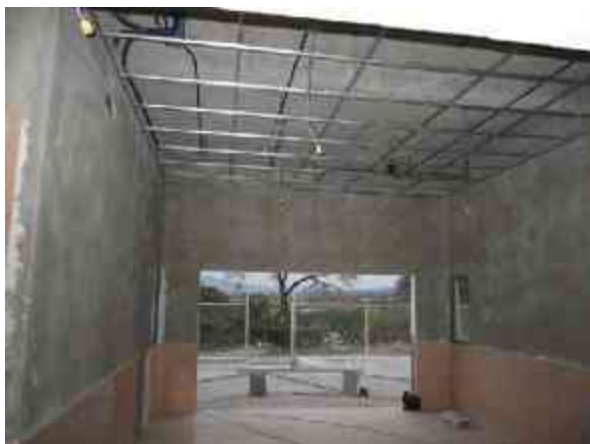
Fig. 78 - Bastidor colgante para plafón de Vestibulo/Control.
