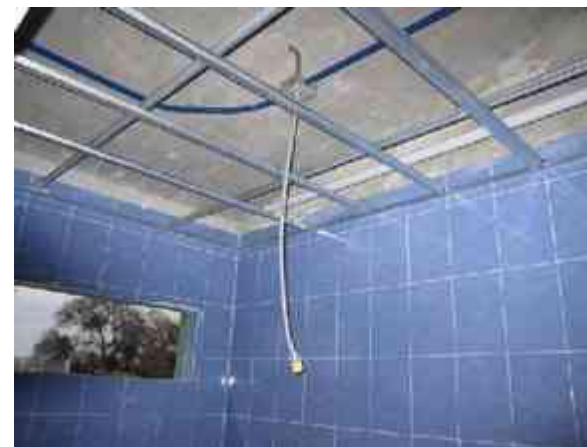
Fig.77 - Bastidor de metal, para recibir panel de tablamento en sanitario.
