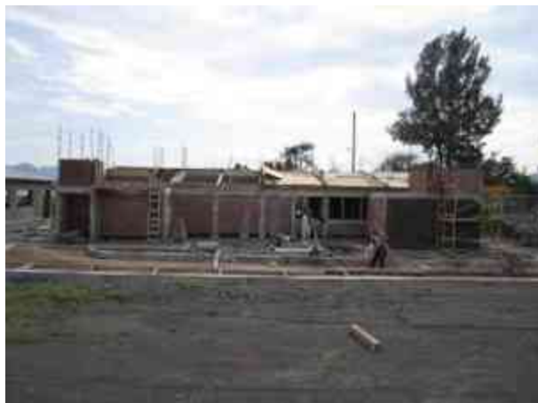
Fig. 48 - Aplanado de muro de tabique, a base de mortero cemento-arena.
