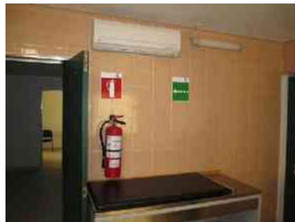
Fig. 123 - Instalación de Mini Split, área de recuperación.
