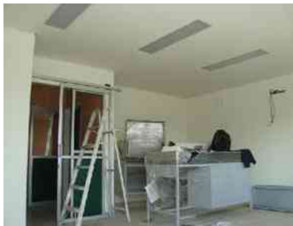
Fig. 57 - Cancel corredizo de Sala de Usos Múltiples.
