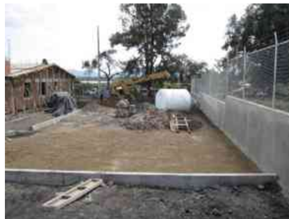
Fig.89 - Maniobra para colocar la planta en la ubicación definida por el residente de Obra.
