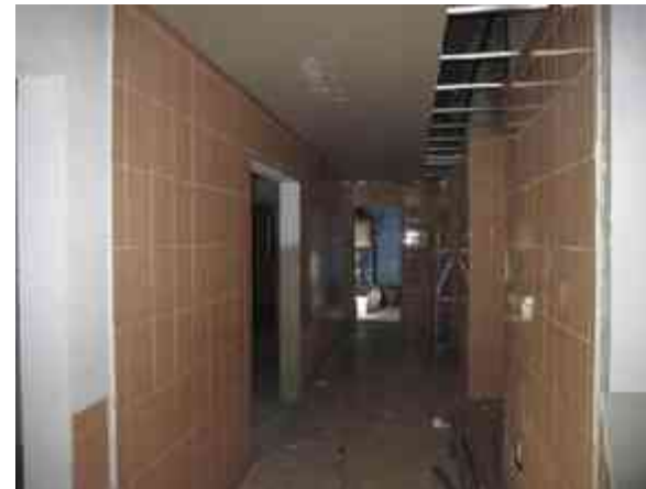
Fig. 79 - Inicio de colocación del falso plafón.
