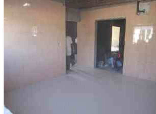
Fig. 45 - Colocación de loseta cerámica color beige de 30x30 cms, en Vestíbulo.
