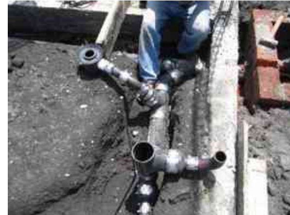
Fig. 85 - Preparación para descarga de Sanitario y lavabo.
