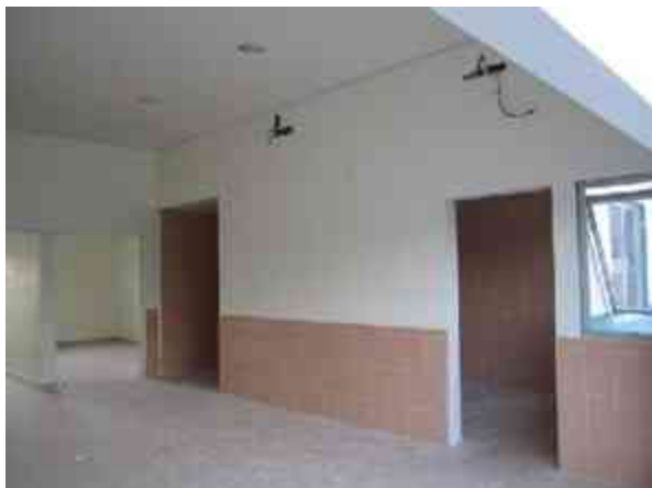
Fig.122 - Preparación para conexión de unidades evaporadoras.
