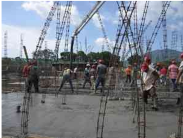
Fig. 32 - Regleado de concreto para nivelar el firme de la Unidad.
