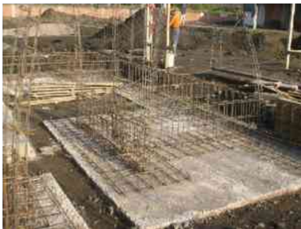
Fig. 22 - Plantilla de concreto pobre para recibir las Zapatas corridas.
