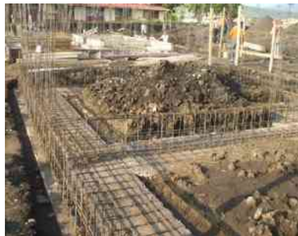
Fig. 23 - Armado de acero en Zapatas y Contratrabe.
