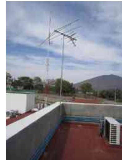
Fig.131 - Antena Logarítmica AM-FM/TV
