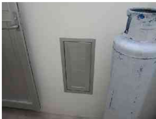
Fig. 58 - Tapa de aluminio para cuadro de válvulas de seccionamiento hidráulico.
