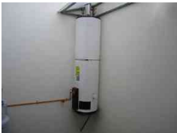
Fig. 118 - Calentador Calorex de 105 lts.
