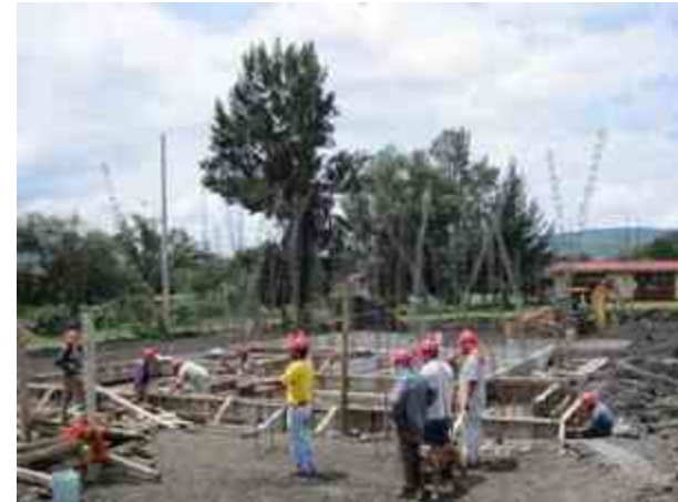
Fig. 25 - Cimbrado para colado de Zapatas.
