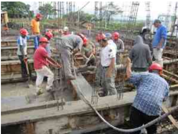
Fig. 26 - Vibrado de concreto para evitar oquedades en las contratraves.
