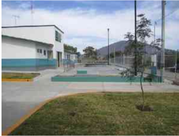
Fig. 168 - Vista de explanada de acceso.
