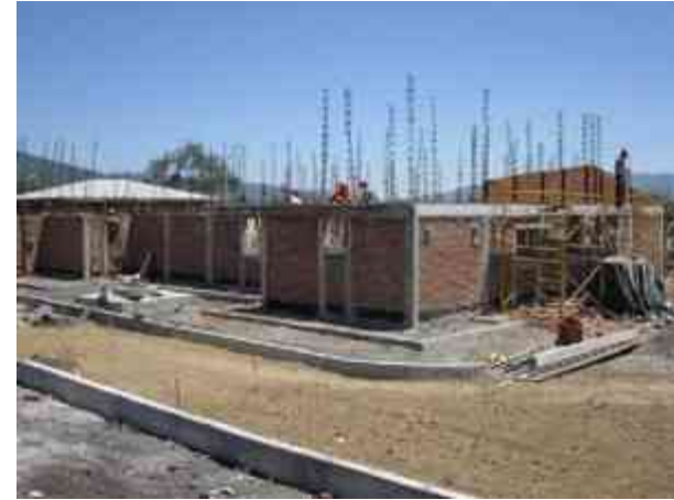
Fig. 37 - Cadena de cerramiento en muro de tabique.
