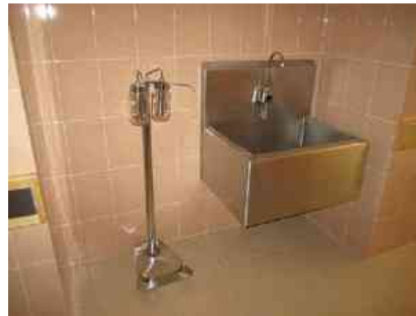
Fig. 159 - Lavado quirúrgico con accionador automático.
