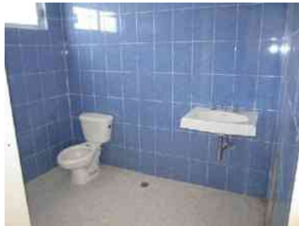
Fig. 69 - Colocación de muebles de baño, sanitario Hombres.
