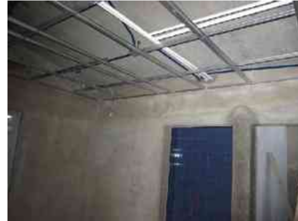
Fig.97 - Tubería de instalación hidráulica pintada color blanco, según especificación de norma IMSS.
