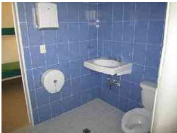
Fig.72 - Colocación de despachador toallas y papel sanitario y jabonera, Baño residencia.
