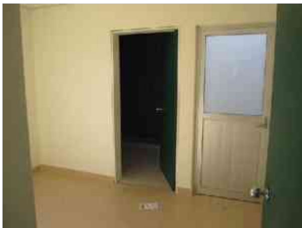
Fig. 54 - Puerta de duela de aluminio a una cara y cristal con película esmerilada de 2 micras.
