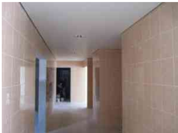
Fig. 50 - Colocación de loseta cerámica en muros color beige, modelo VERONA de LAMOSA.
