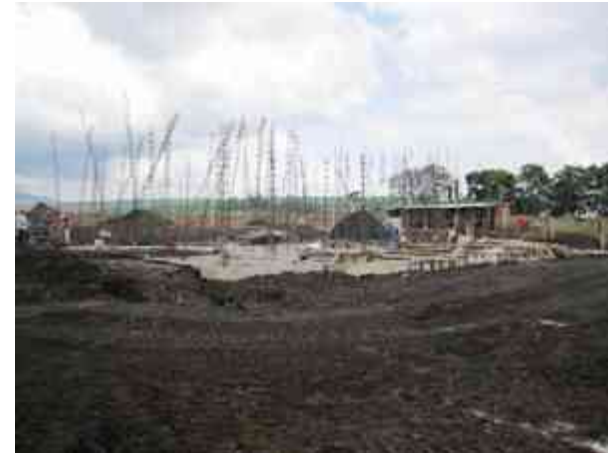
Fig. 29 - Descimbrado de Zapatas.
