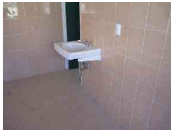
Fig. 71 - Colocación de lavabo en recuperación.
