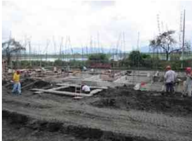
Fig. 28 - Retiro de bastidores de triplay de las zapatas y contratraveses.
