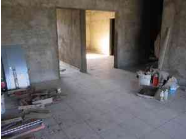
Fig. 44 - Colocación de loseta cerámica color beige de 30x30 cms, modelo ECONOS de LAMOSA.
