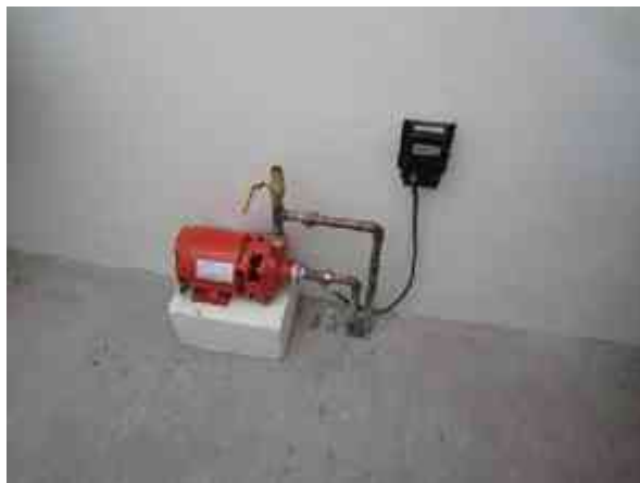
Fig. 106 - Instalación de bomba eléctrica con electronivel para llenado automático de tinaco,
