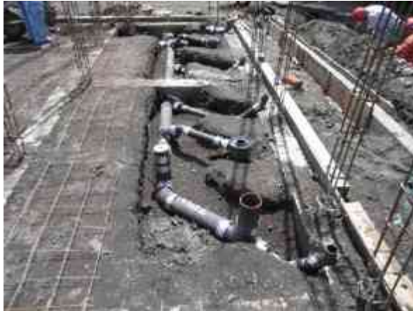
Fig. 84 - Red sanitaria a base de FoFo ensamblado con empaque de neopreno con sellador y abrazadera de acero inoxidable sin fin.
