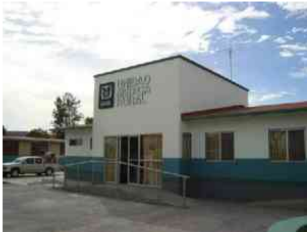
Fig. 170 - Rampa de acceso a la Unidad.
