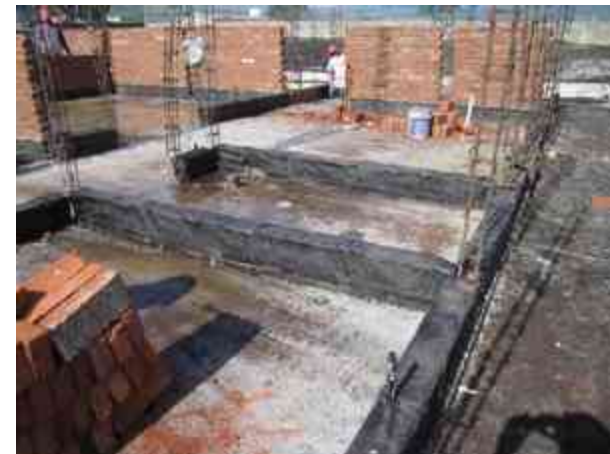
Fig. 35 - Aplicación de impermeabilizante, según lo indica la norma del IMSS.
