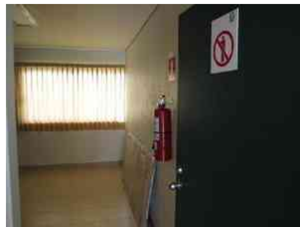
Fig. 147 - Acceso restringido a farmacia.
