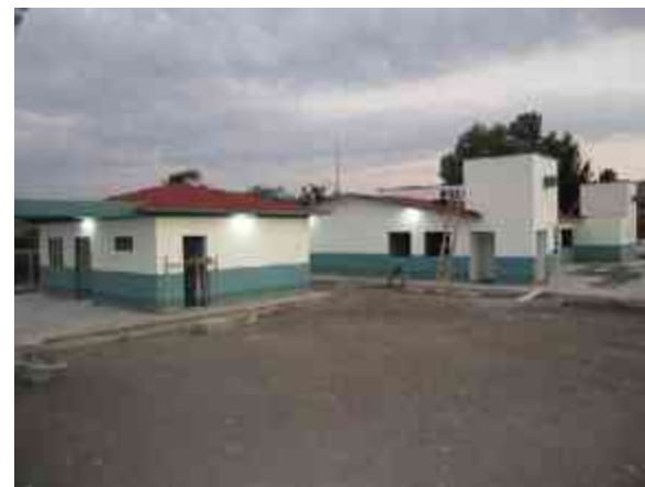
Fig.113 - Luminarias en parte lateral de la Unidad y del C.A.R.A.
