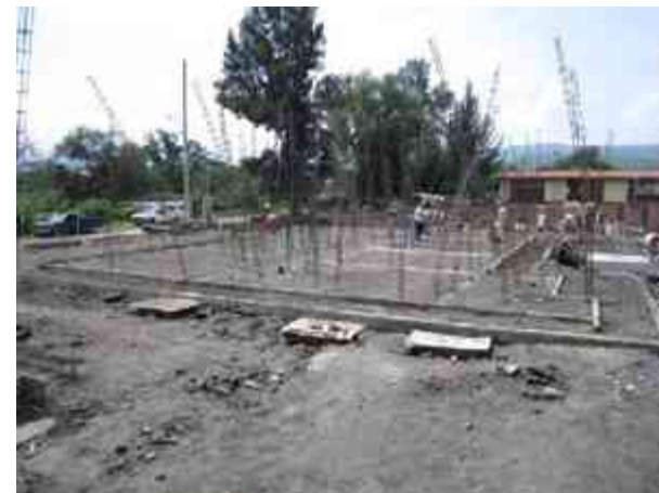
Fig. 31 - Nivelación del relleno de Zapatas, para recibir el firme de concreto armado.
