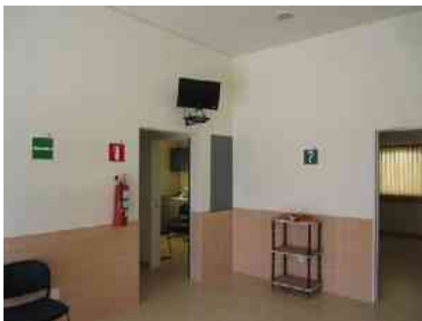
Fig. 136 - Acceso a sanitarios visitantes, aseo y Residencia medica.
