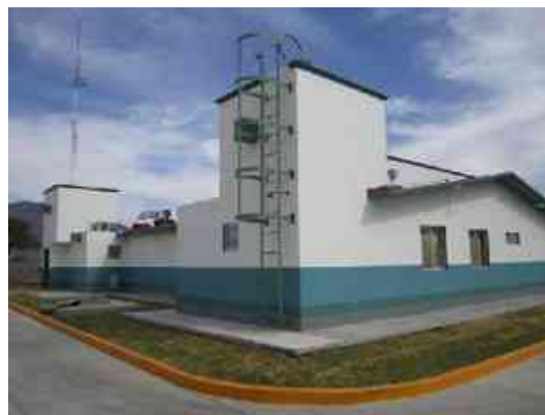
Fig. 65 - Escalera Marina a base de barandal de tubo de 1-1/4" Ced. 40 cinturón de solera de 3x1/4".
