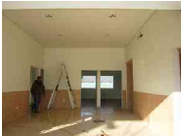
Fig. 82 - Falso plafón terminado de vestíbulo/control.
