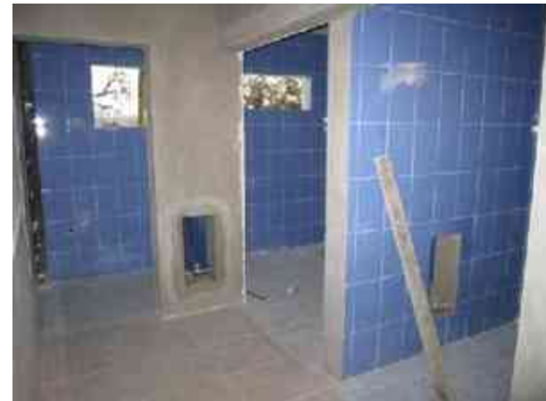
Fig. 47 Colocación de loseta cerámica, color gris de 20x20 cms, modelo DIAMANTE de LAMOSA.
