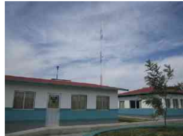
Fig. 171 - Acceso a Sala de usos múltiples.
