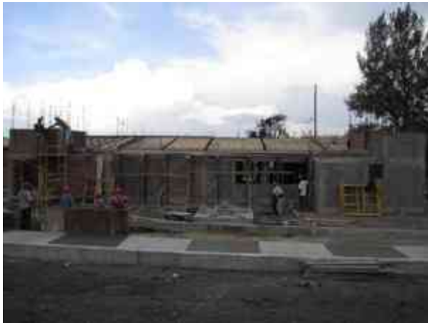
Fig. 38 - Proceso de cimbrado, a base de hoja de triplay de 1" de espesor.
