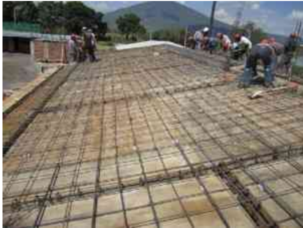
Fig. 40 - Armado de parrilla de acero para losa de cubierta.
