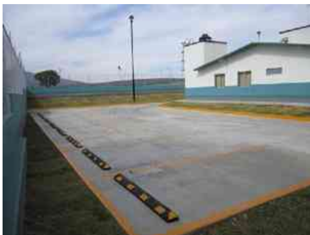
Fig. 166 - Topes para cajones de estacionamiento.
