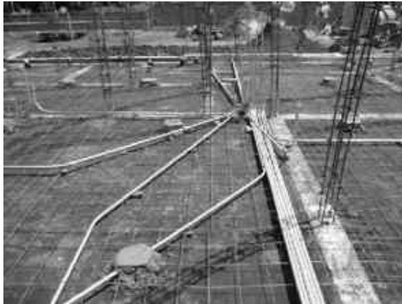
Fig.100 - Colocación de tubería conduit pared gruesa para instalación eléctrica.
