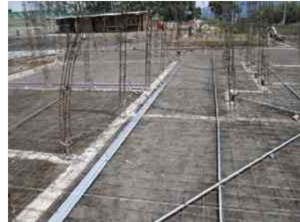
Fig.101 - Canalización para cableado de contactos.
