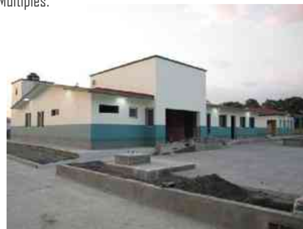
Fig. 51 - Aplicación de pintura sobre muro de tabique aplanado a base de mortero cemento-arena.
