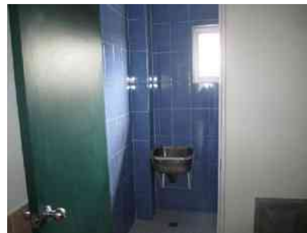
Fig. 137 - Cuarto de Aseo, cuenta con vertedero, para facilitar los trabajos de limpieza.
