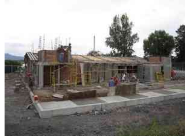
Fig. 39 - Cimbra para colado de la losa de cubierta.
