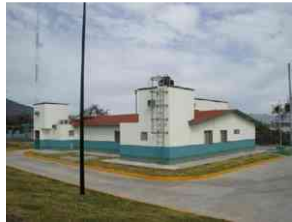
Fig. 175 - Escalera marina para acceder al tinaco.
