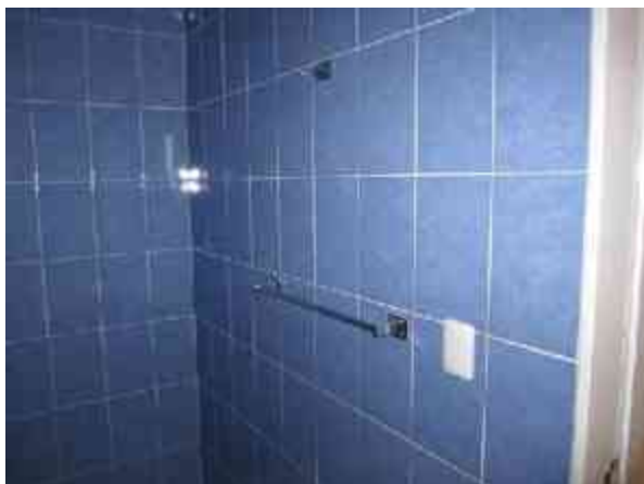
Fig. 74 - Colocación de toallero y gancho de pared.
