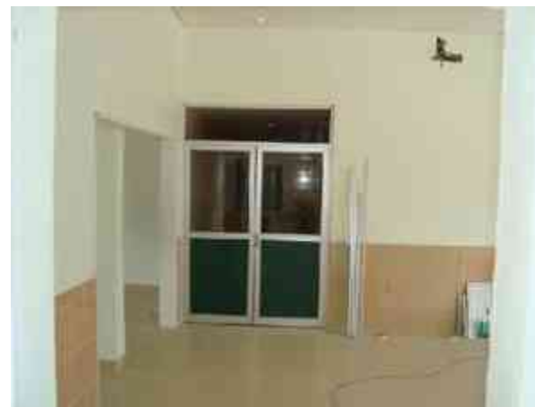
Fig. 53 - Colocación de puerta de a base de aluminio color natural y cristal en acceso a la Unidad.
