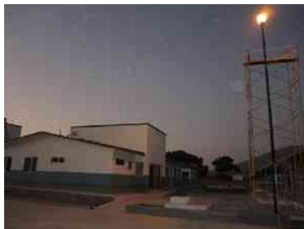
Fig. 114 - Luminarias de iluminación, en exterior de la plaza de acceso.
