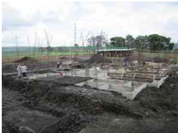
Fig. 30 - Relleno de Zapatas con material producto de excavación.
