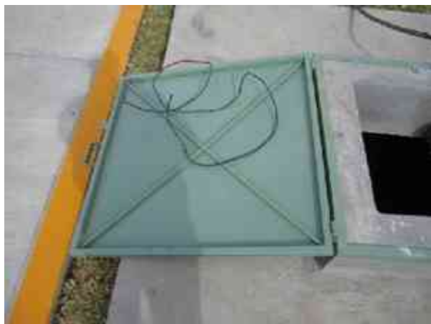
Fig. 64 - Tapa de cisterna a base de PTR de 1x1" y lámina cal. 18.
