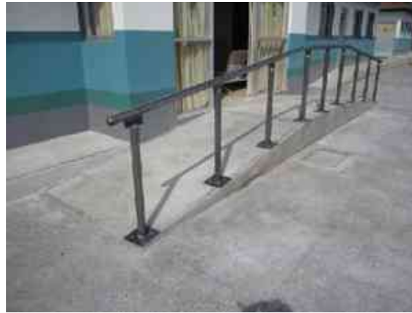
Fig. 67 - Barandal en rampa hecho de Poste de acero ced. 30 de 2 y 3", y placa de acero de 1/8 y 3/8".
