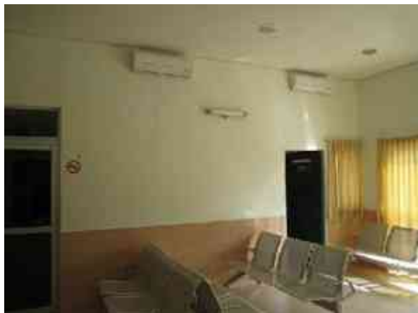
Fig. 110 - Instalación de Unidades Evaporadoras de aire (Minisplit).
