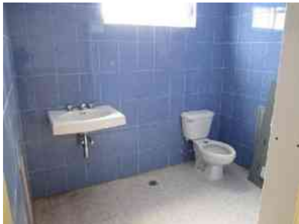
Fig. 68 - Colocación de muebles de baño, sanitario Mujeres.
