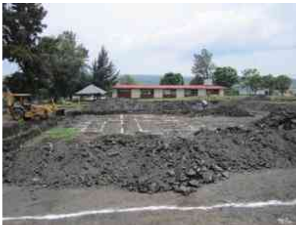
Fig. 20 - Trazo de cimentación en el predio.
