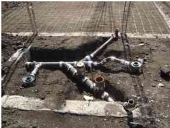
Fig. 86 - Instalación sanitaria de baño de recuperación.
