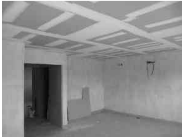
Fig.80 - Aplicación de prefacinta y redimix en placas de yeso, para calafateo de junta entre panel y panel.
