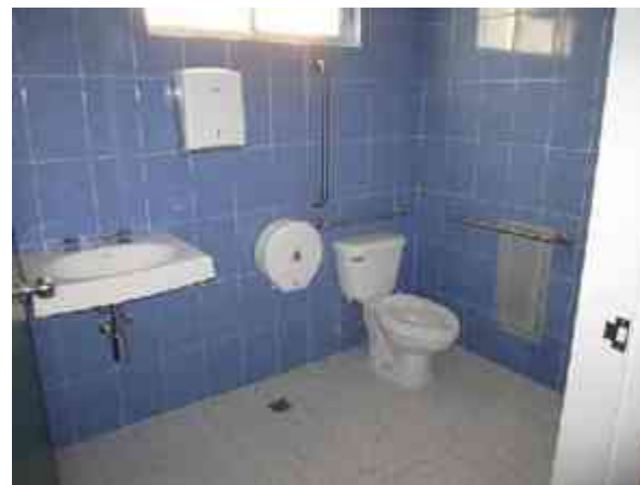
Fig.73 - Colocación de despachador toallas y papel sanitario y barras de apoyo, sanitario Mujeres.
