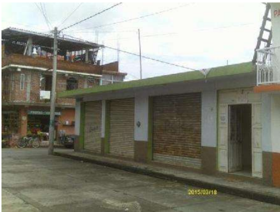
Ilustración 21. Vista del terreno 1 sobre calle Tenochtitlan de sur a norte. J.M.U.T
