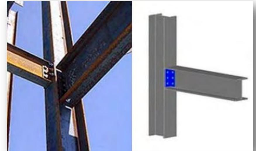
Ilustración 65. Unión apornada de viga y columna metálica. Fuente Web: <http://es.slideshare.net/william0388/uniones-y-conexiones-en-estructuras-de-acero> (Acceso Mayo 14 del 2015).
