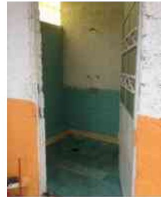
IMAGEN 11 , BAÑO PARA TODA LA BASE ACTUAL, FUENTE PROPIA. 18 NOVIEMBRE 2014.
