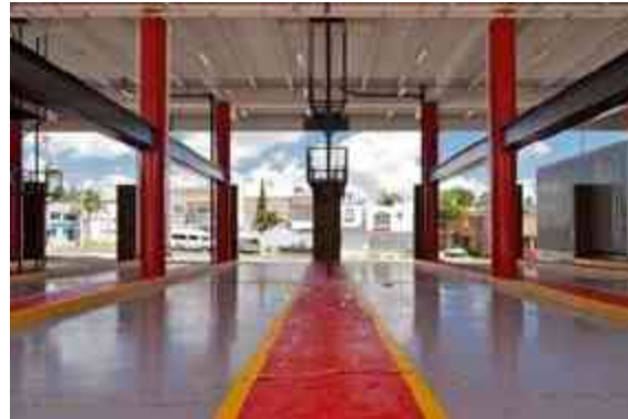
IMAGEN 33. FUENTE. HTTP://COMERCIALIZADORAGOAL.MEX.TL/PHOTO_1235270_EDIFICIO-BOMBEROS-Y-PROTECCION-CIVIL-DE-ZAPOPAN-TERMINADO.HTML . DICIEMBRE 2014.
