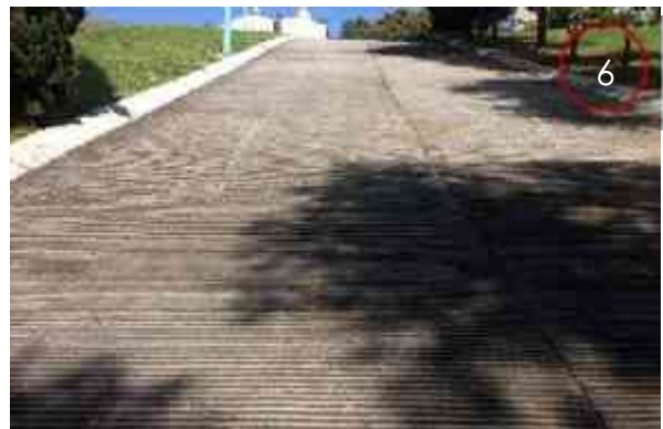
IMAGEN 57. ACCESO AL FRACCIONAMIENTO "LAS LOMAS" CON ORIENTACIÓN AL ORIENTE, SE PUEDE APRECIA LA INCLINACIÓN CON LA QUE CUENTA. FUENTE PROPIA. DICIEMBRE 2014.
