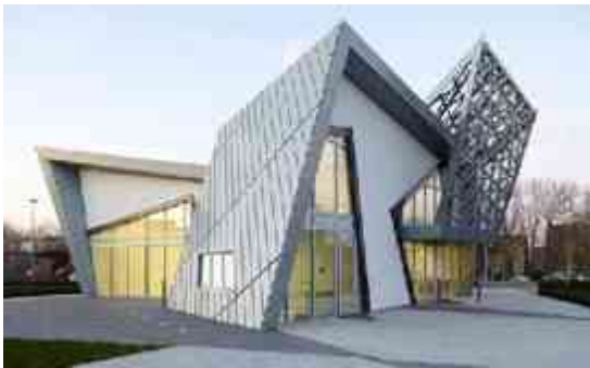
IMAGEN 18, CASA DISEÑADA POR DANIEL LIBESKIND. FUENTE. INESTABILIDAD, HTTP://BELENFEBRE-IMD2013.BLOGSPOT.MX/2013/09/INESTABILIDAD-DECONSTRUCTIVISMO.HTML . CONSULTA. MAYO DEL 2015
