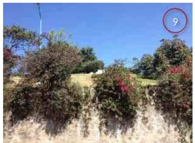
IMAGEN 60. VISTA HACIA EL NORTE, DEL EXTERIOR AL INTERIOR DEL TERRENO, DONDE SE APRECIA COMO EL MURO DE CONTENCIÓN ESTÁ RETENIENDO PARA EVITAR QUE SE DESBORDE EL TERRENO. FUENTE PROPIA. DICIEMBRE 2014.
