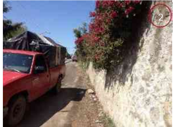
IMAGEN 53. VIALIDAD PRINCIPAL HACÍA EL SUR, SE OBSERVA UN MURO DE CONTENCIÓN QUE EVITA DERRUMBES Y DELIMITA EL FRACCIONAMIENTO. FUENTE PROPIA. DICIEMBRE 2014.
