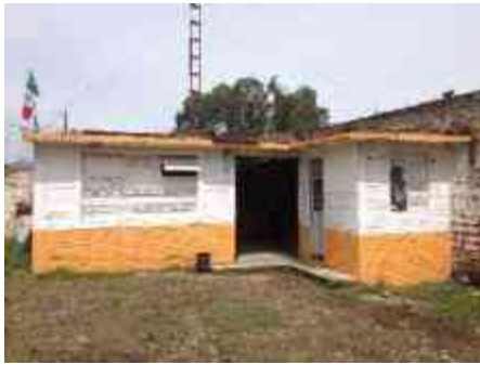
IMAGEN 7 , ACTUAL ÁREA DE CONTROL Y OPERACIÓN. FUENTE PROPIA. 18 NOVIEMBRE 2014.
