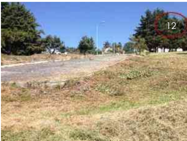
IMAGEN 63. VISTA AL NORT-PONIENTE, SE PUEDE VER LA DELIMITACIÓN DEL TERRENO HACIA LA CALLE Y COMO ANTERIORMENTE SE MENCIONÓ QUE TODA EL TERRENO ESTARÁ DELIMITADO CON UNA BARDA PERIMETRAL, AQUÍ ESTARÁ PARTE DE ELLA. FUENTE PROPIA. DICIEMBRE 2014.
