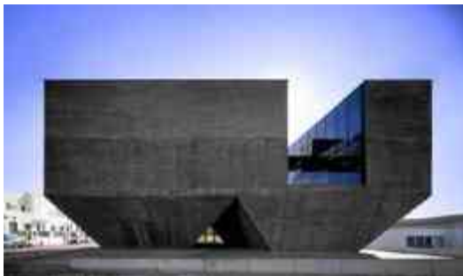
IMAGEN 20, CENTRO INTEGRAL TERRITORIAL DE LA MANCOMUNIDAD DE OLIVENZA. AUTOR DE FOTOGRAFÍA, JESÚS GRANADA. FUENTE. HTTP://NOTICIAS.ARQ.COM.MX/DETALLES/15016.HTML#LWVKMR08N_GC . CONSULTA. MAYO 2015.
