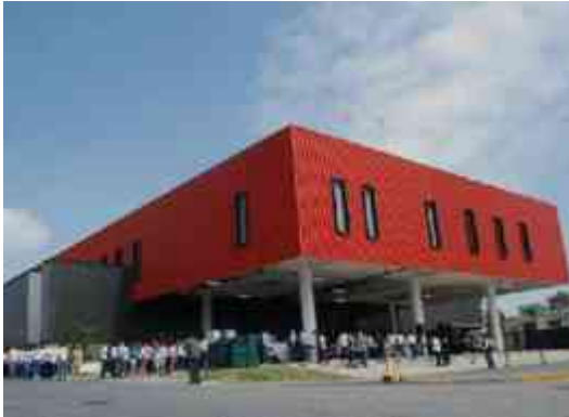
IMAGEN 32. FUENTE. HTTP://COMERCIALIZADORAGOAL.MEX.TL/PHOTO_1235270_EDIFICIO-BOMBEROS-Y-PROTECCION-CIVIL-DE-ZAPOPAN-TERMINADO.HTML . DICIEMBRE 2014.
