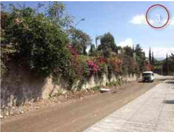
IMAGEN 54. VIALIDAD PRINCIPAL HACÍA EL SUR, SE OBSERVA QUE ESTÁ EN PROCESO LA PAVIMENTACIÓN. CON VISTA FOTOGRÁFICA HACIA EL ORIENTE, FUENTE PROPIA. DICIEMBRE 2014.
