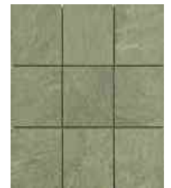
PISO DE CONCRETO MARTELINADO, ACABADO RUSTICO CON UNA RETICULA DE 40 CM X 40CM
