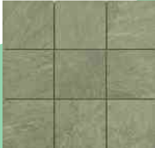
PISO DE CONCRETO MARTELADO, ACABADO RUSTICO CON UNA RETICULA DE 40 CM X 40CM
