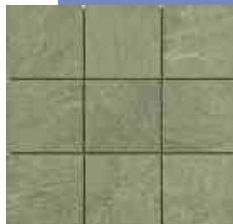
PISO DE CONCRETO MARTELINADO, ACABADO RUSTICO CON UNA RETICULA DE 40 CM X 40CM
