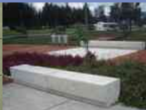
BANCAS DE CONCRETO DE FORMA RECTANGULAR, DE ALTURA 0.50 MT., ANCHO 0.60 MT. Y LAGO DE 3 MT.
