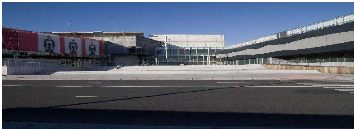
Imagen 2, Recinto ferial de Coruña España, consultado en: www.nferias.com , 5 de octubre del 2014.
