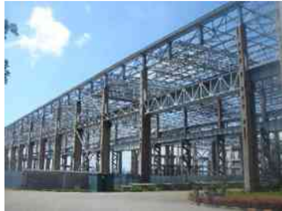
Imagen 83 Estructura de acero. Foto obtenida del Catálogo de Arquitectura.
