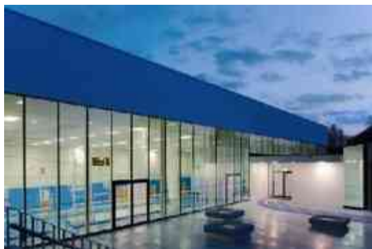
Imagen 58 Entrada al área de alberca http://arqa.com/arquitectura/polideportivo-caja-azul.html
