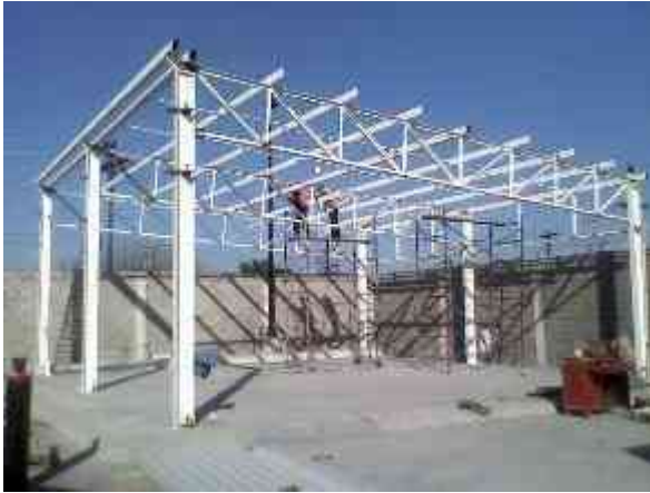
Imagen 86 Cubierta tipo Joist https://toldosyestructuras.wordpress.com/quienes-somos/
