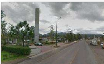
Imagen 33.- Fotografía de la Antigua Carretera a Pátzcuaro, frente al hito de la Ciudad del Conocimiento. Por Juan A. Camarillo León
