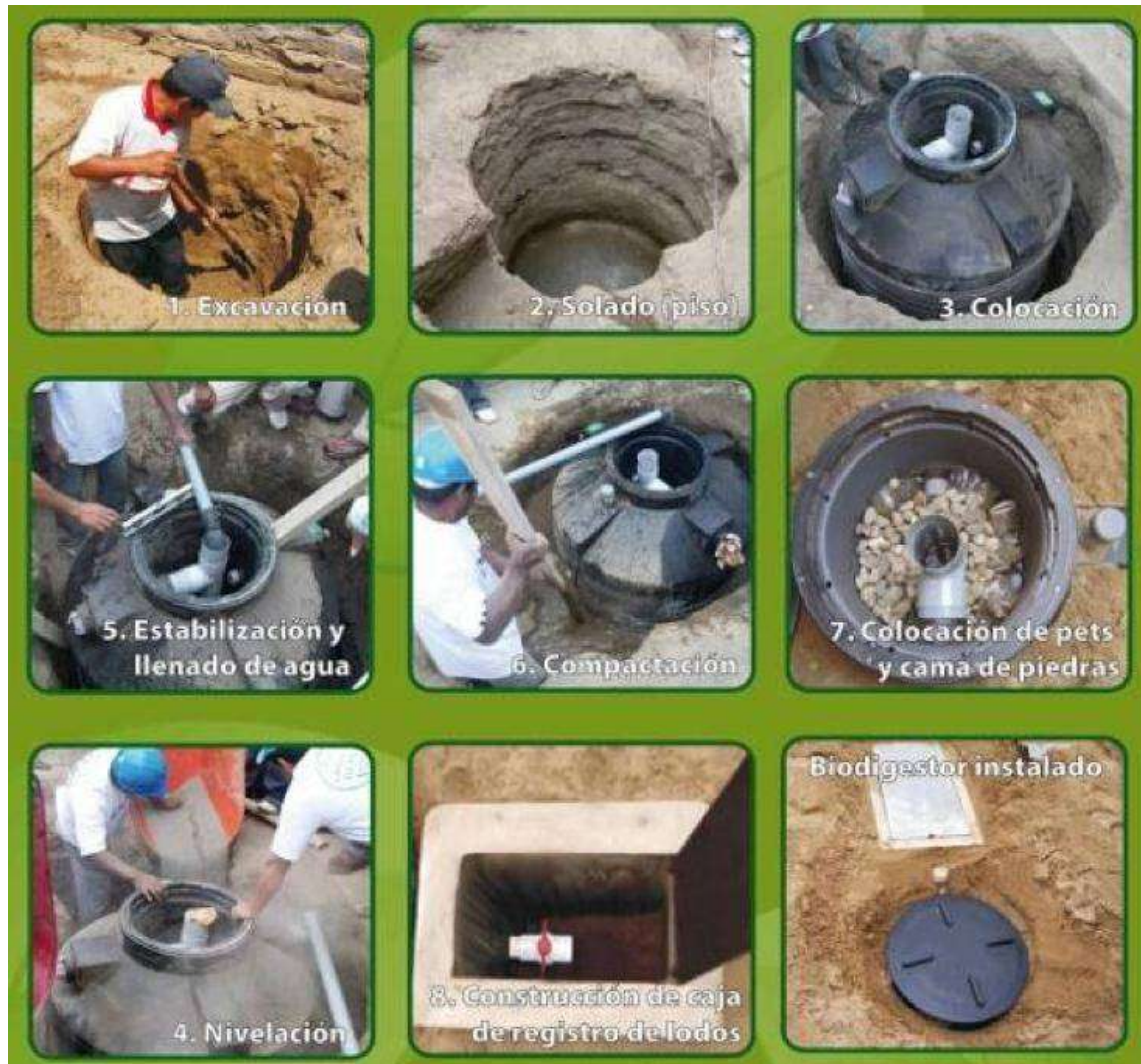
Imagen 121.- Esquema de instalación de un Biodigestor.
