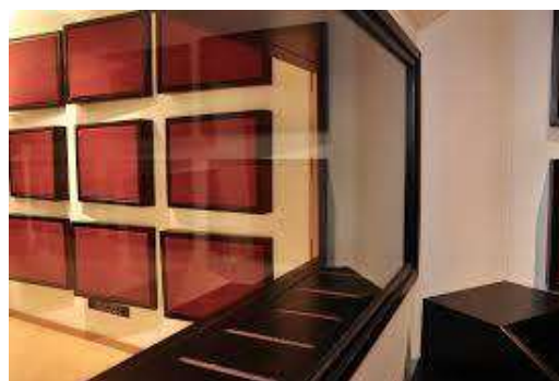
Imagen 146.- Ventana acústica estática de doble acristalamiento, sellada al vacío.. Google imágenes.
