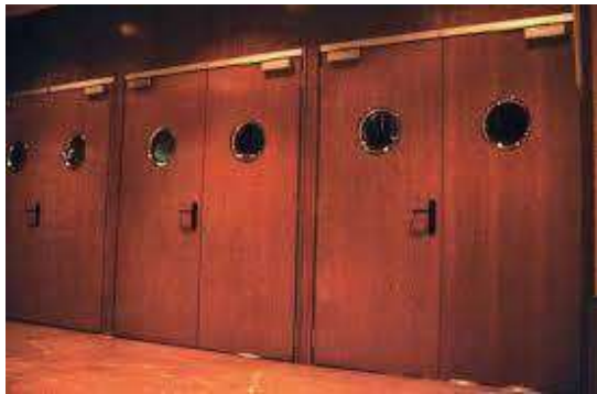
Imagen 140.- Puertas de submarino con marco completo de goma. Google imágenes.
