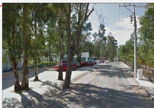
Imagen 30.- Frente del terreno de donación sobre calle Camino de la Arboleda, cuenta con líneas de alumbrado público.
