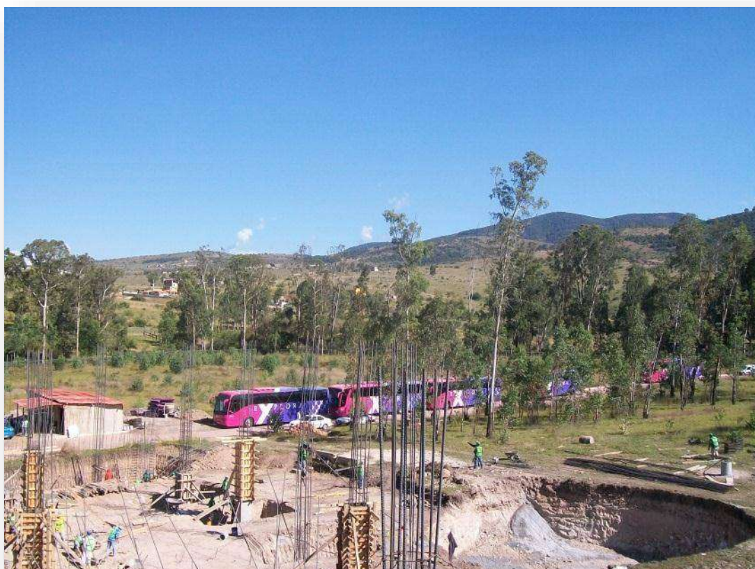
Imagen 10.- Excavación para cimentación de la ENES localizada al norte del terreno, en ella se apreciara la profundidad a la que se encuentra la cantera. Fotografía de Jonathan Mata H. Noviembre 2012.
