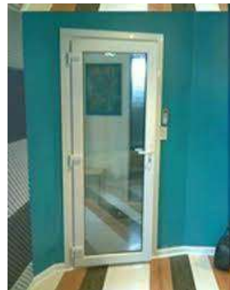
Imagen 143.- Puerta acústica de doble cristal con marco completo de goma. Google imágenes.
