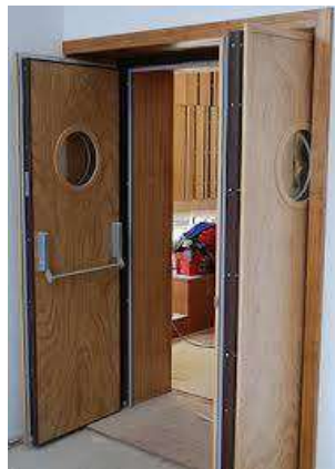
Imagen 142.- Puerta tipo submarino, rellena de arena fina, con bisagras de acero reforzado. Google imágenes.
