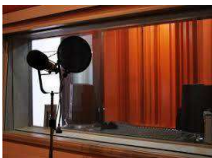
Imagen 130.- Ventanilla de comunicación entre cabinas de locución y operación, estilo clásico. Fotografía por Juan A. Camarillo León.
