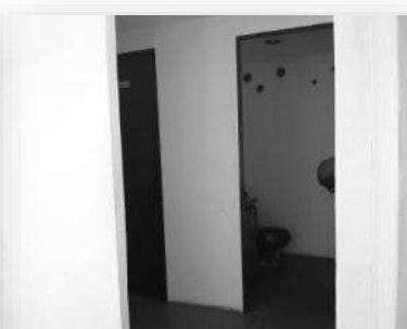
Imagen 65.- Fotografía de los baños temporales, durante la remodelación del lugar, están hechos de duroc sobre una estructura metálica, capacidad para un hombre y una mujer. Por Juan A. Camarillo León.
