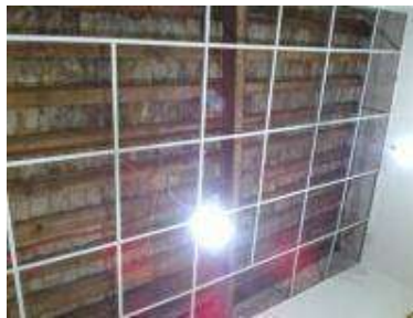
Imagen 150.- Colocación de estructura para plafón en losacero. Fotografía por Juan A. Camarillo León
