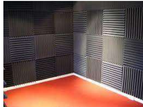
Imagen 139.- Terminado de muro acústico, con texturizado en bloques de unicel. Google imágenes.
