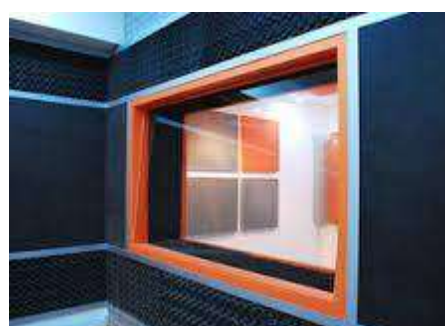
Imagen 131.- Ventanilla de comunicación entre cabinas de locución y operación, estilo contemporáneo. Fotografía por Juan A. Camarillo León.
