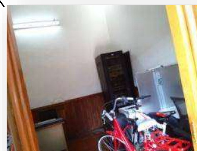
Imagen 74.- Fotografía del cuarto de maquinas. Debido a la remodelación y mantenimiento en que se encuentra la estación en el día de la visita, es improvisado como almacén. Por Juan Antonio Camarillo León.
