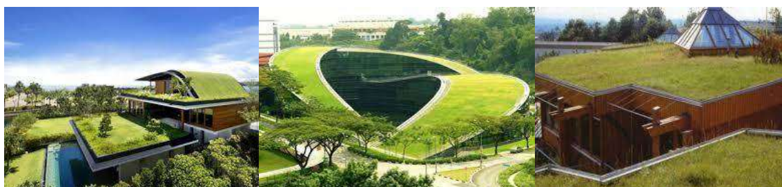
Imagen 115.- Azoteas verdes, como elemento estructural, ecológico y de paisajismo. Google imágenes.
