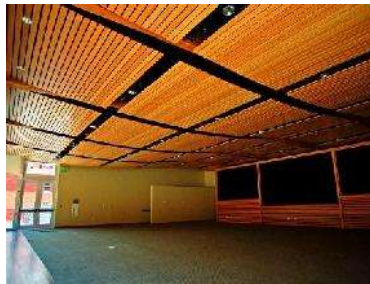
Imagen 152.- Cubierta colgante de madera laminada. Google imágenes.
