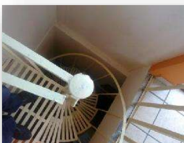
Imagen 52.- Fotografía de la escalera de caracol para acceder a la cabina de programación en la 2ª planta, el radio de esta es calera es de 50cm, dentro de un cubo de 1m². Por Juan A. Camarillo León.
