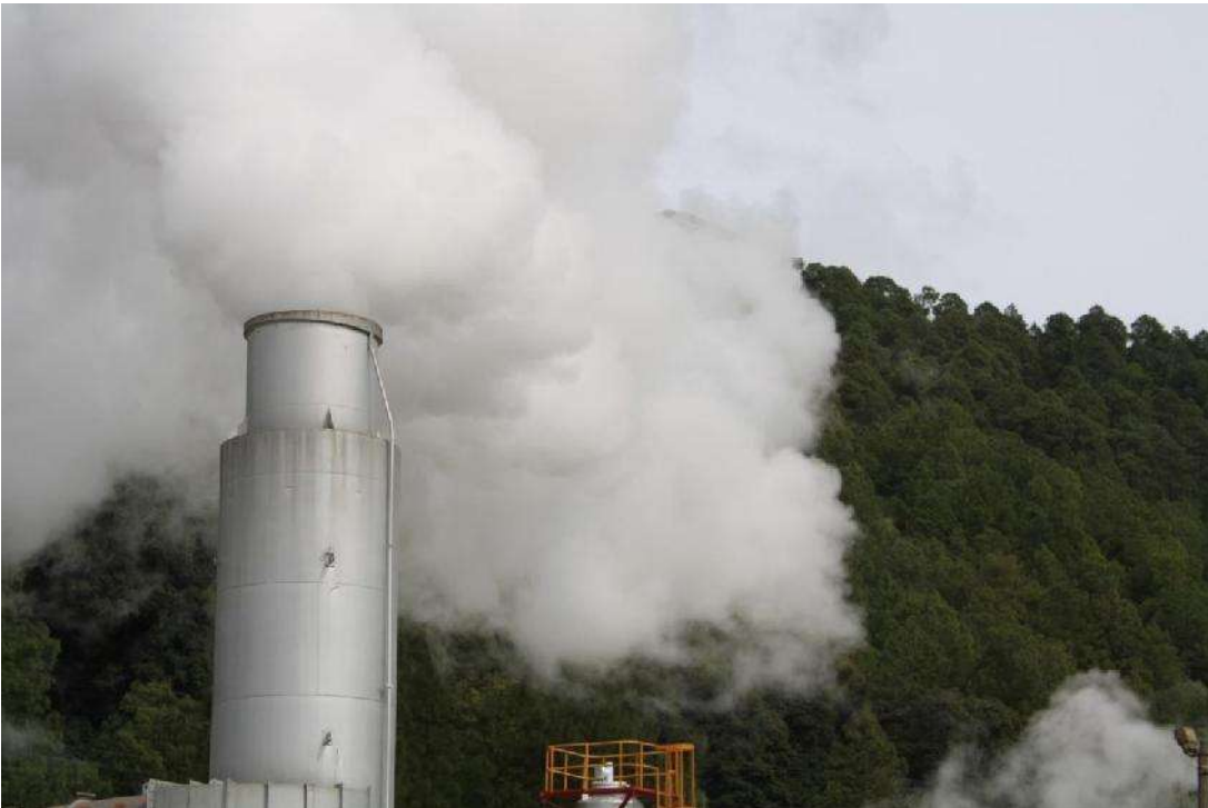
Fig. 122 Pozos de extracción, Los Azufres, Hgo. Tomada por GLP, el 12 de Enero de 2015.
