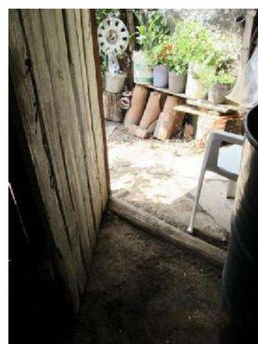
**cimientos de mampostería      muros de madera y textiles      pisos de tierra compactada**
